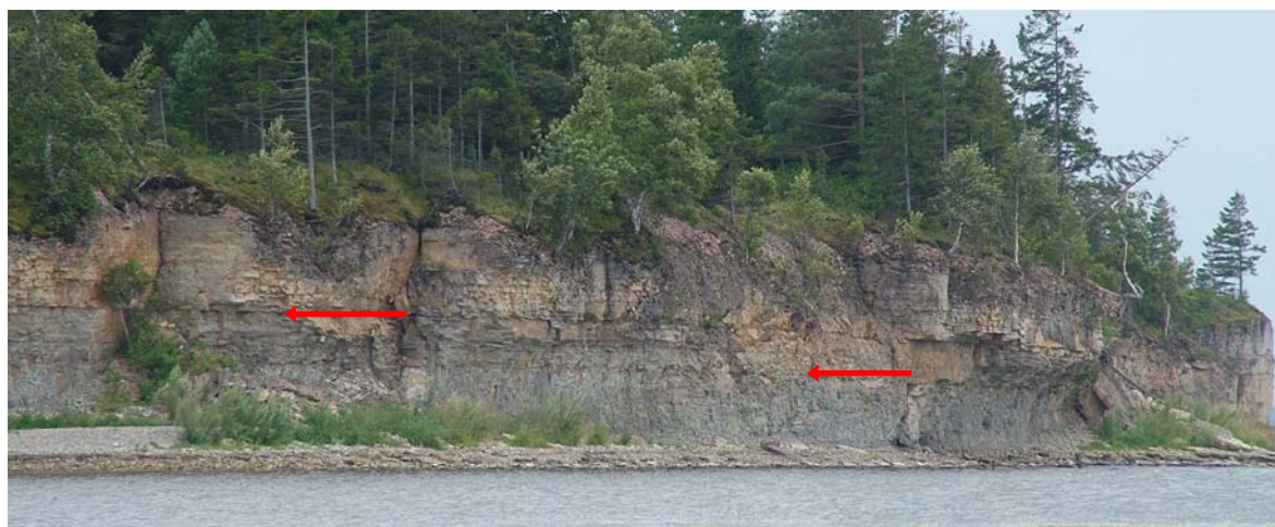
Foto 18. Kesse panga Suursääre poolne ots (I lõigu lõpp). Vertikaalne klindisein, milles näha selge kivimiline kolmikliigestus – nooled eristavad, all Jaani lademe savikad domeriidid, keskel sama lademe vähemsavikad domeriidid ja üleval Jaagarahu lademe plaatjad dolomiidid (foto I. Tuuling).
