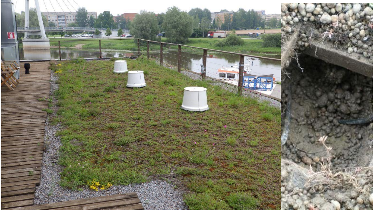
Pilt 1. Archimedese kergmurukatus ja selle kergkruusakiht.
