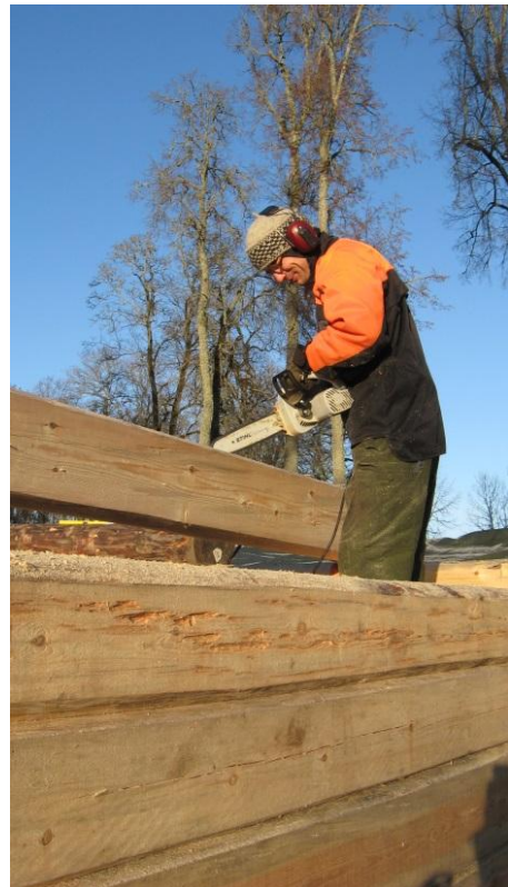
Foto 5 Tapi ja vara lõikamine elektrilise mootorsaega (M.Aron)
