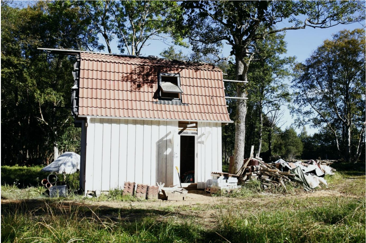
Foto 16 Hoone kaetud välisvoodri laudadega (M.Aron)
