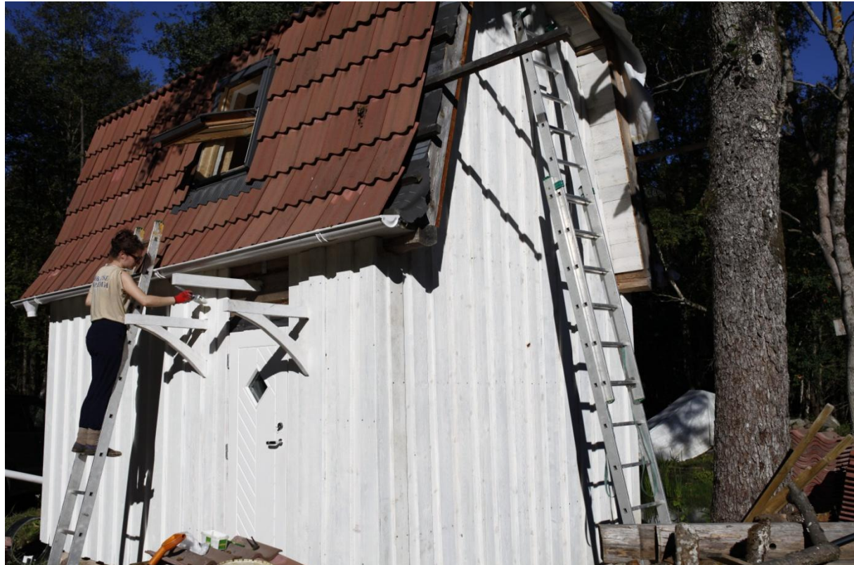
Foto 17 Hoone värvimine linaõli värviga (M.Aron)
