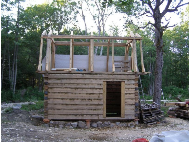
Foto 9 Vundamendile püstitatud puitkonstruktsioonid (M.Aron)
