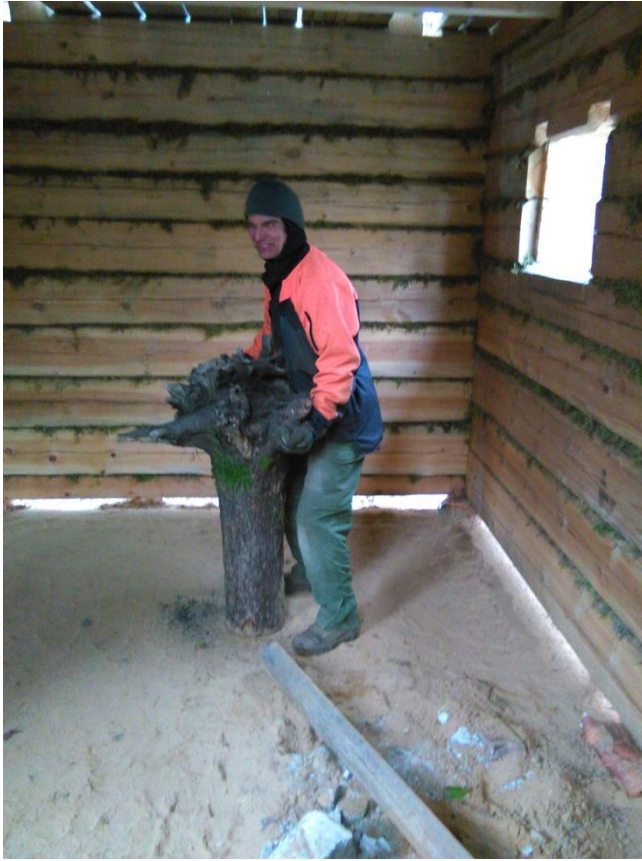
Foto 12 Hoone aluse liivapinnase tihendamine agregaadiga „Kännuämblik 3000 TDi“ (K.Annama)
