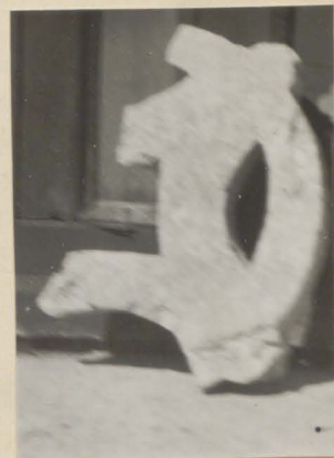
Pilt №42. Oma foto. Vana purunenud kivist tük, mis maapõnest nähtavale tulnud jõelähtme kiriku välimise remondi ajal (1933 a.).
