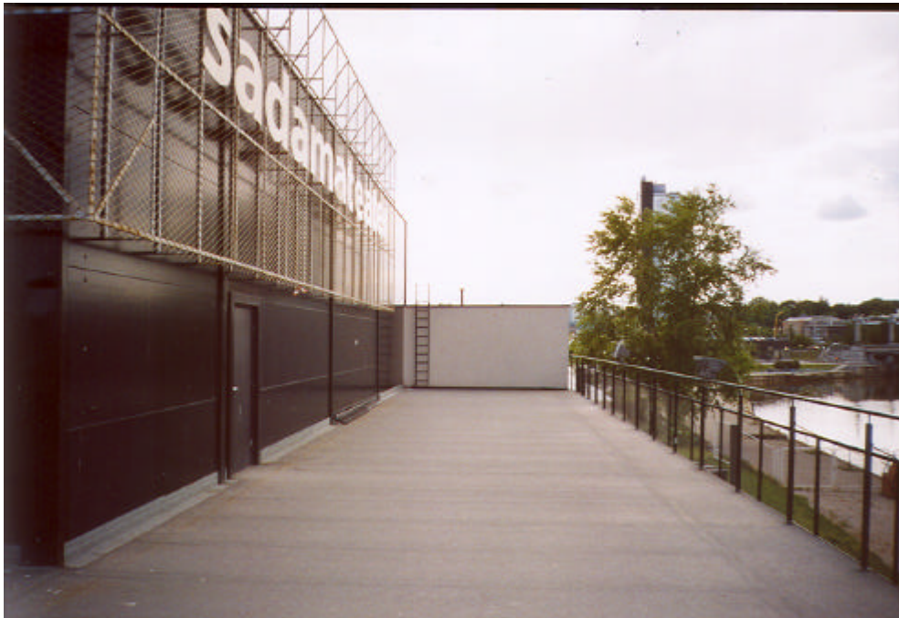
Joonis 25. Võrdluskatuseks olev Sadamateatri bituumenkattega terrasskatus.
