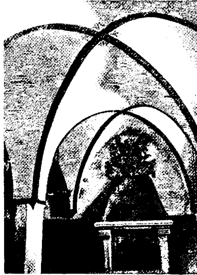
Abb. 148. Arensburg, das Dormi- torium im Nordflügel.
