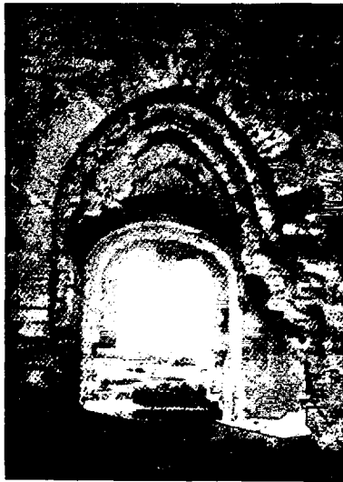
Abb. 9. Kokenhusen, Fenster in der Südmauer.
