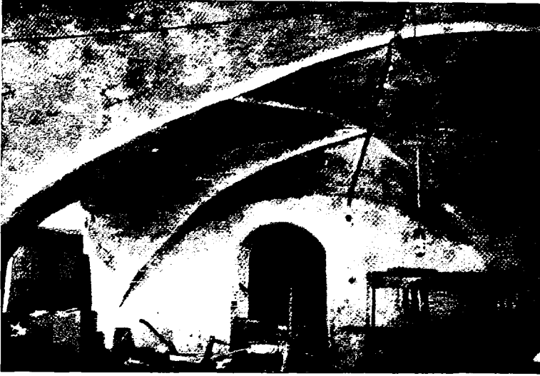
Abb. 114. Neuenburg, Raum im Kellergeschoss.
