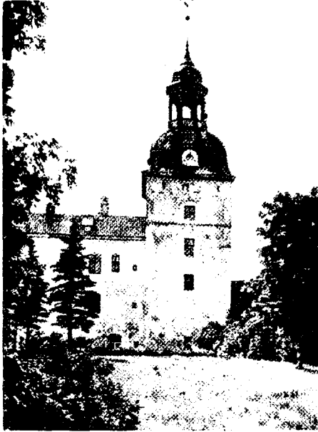
Abb. 55. Gross-Roop, der Hauptturm von Nordwesten gesehen.
