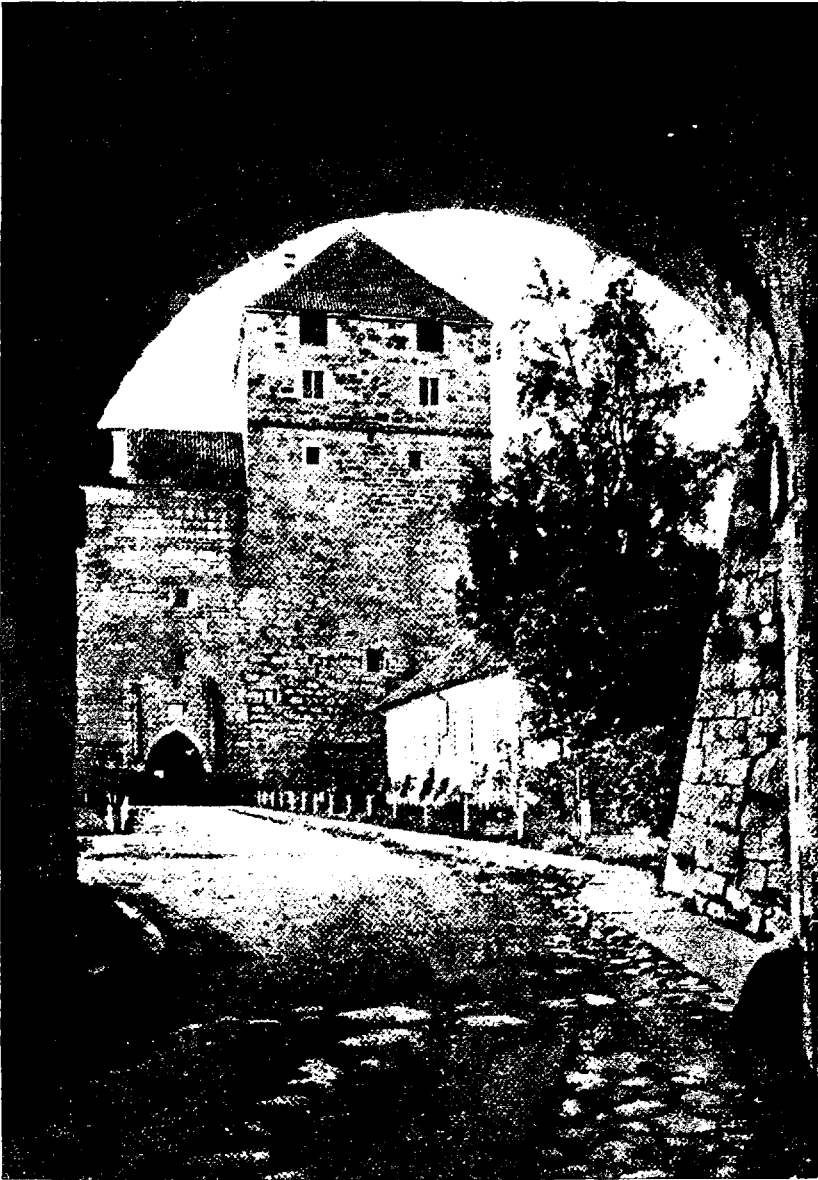
Abb. 141. Arensburg, Ansicht des Schlosses von Norden durch das Bastionstor.
