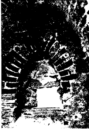
Abb. 231. Wenden, eine Schiesskammer im oberen Stockwerk des „Langen Hermann“.
