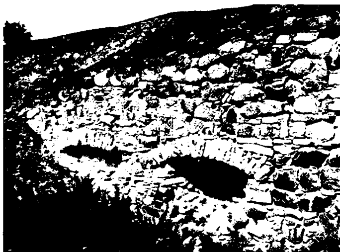
Abb. 117. Soneburg, Schiessscharten an der Südfront.
