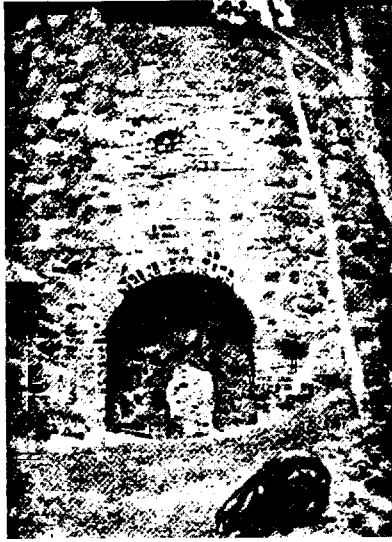
Abb. 201. Ermes, Haupteingang mit Fallgatternische.
