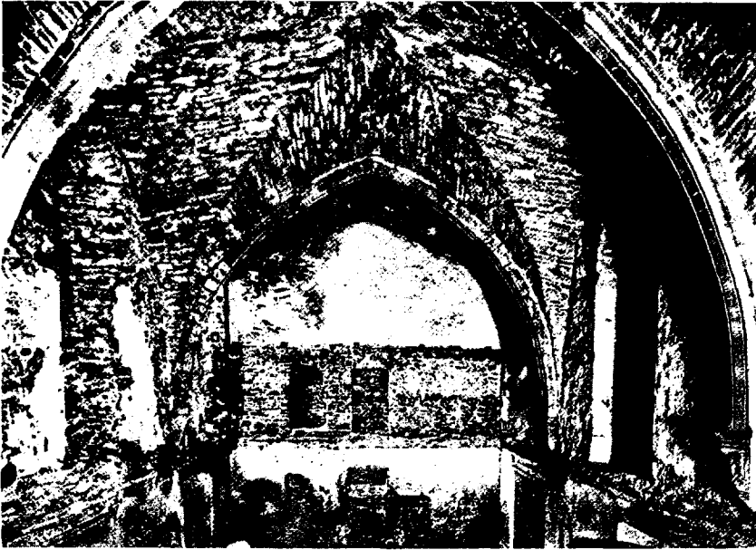
Abb. 189. Padis, Ansicht der Kirche gegen Nordosten.
