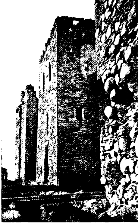
Abb. 220. Tolsburg, Ansicht von Südosten.
