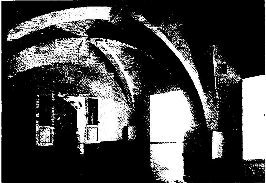
Abb. 92. Riga, Raum im ersten Stockwerk des Schlosses.
