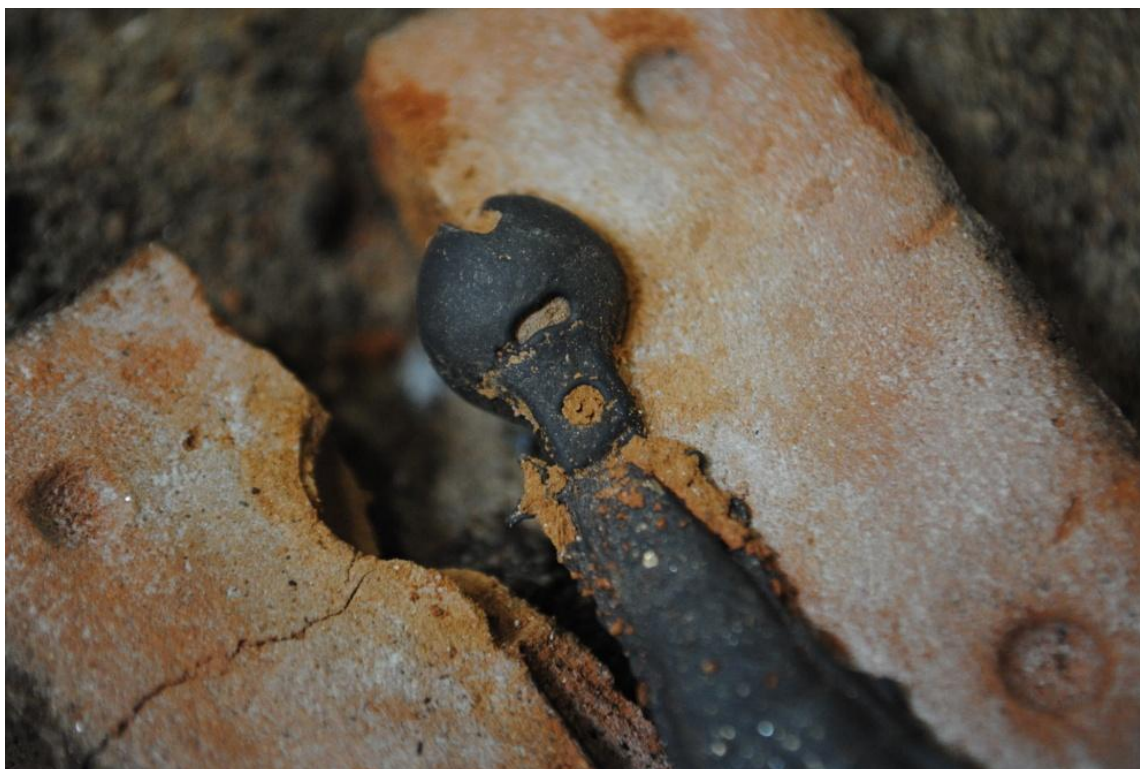
Foto 10. Valudefekt kuljuse aasapoolses osas
