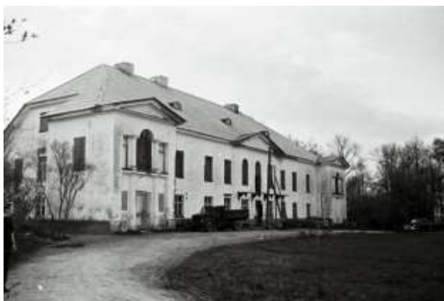
Kasti mõisa peahoone esikülg. 1963. Foto: Veljo Ranniku, https://register.muinas.ee/public.php?menuID=photolibrary&action=view&id=2406 (vaadatud: 19.11.2017).
