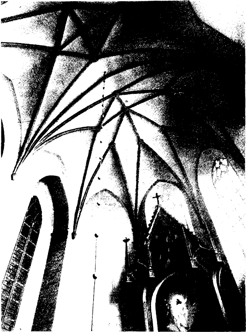
Abb. 6. Das Gewölbe der Marienkapelle. Photo A k e l.
