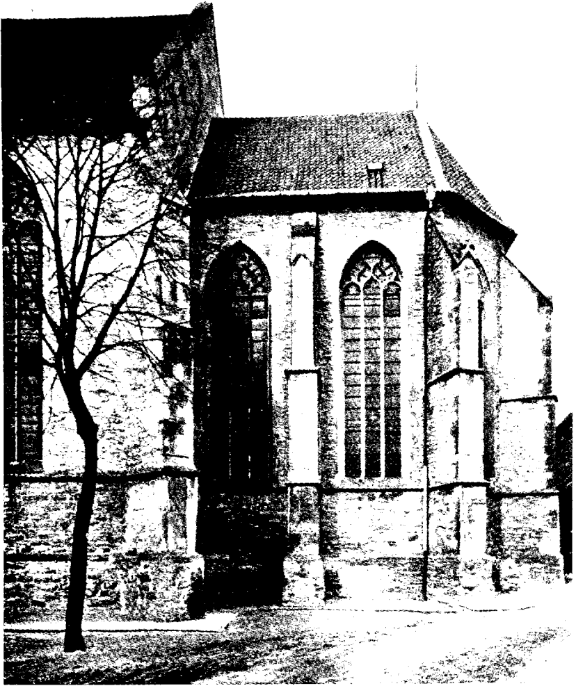
Abb. 8. Die Pfarrkirche in Everswinkel. Chor von Süden. Nach Bau- und Kunstdenkmäler von Westfalen.
