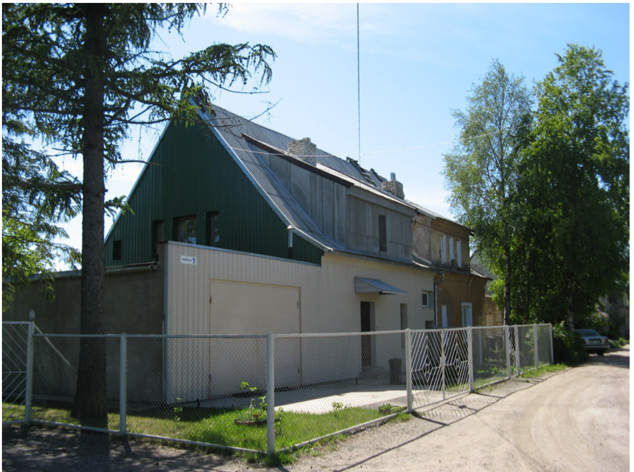
Joonis 4. Hoone välisfassaadi on renoveeritud ning materjalid on asendatud ajastule ebakohaste materjalidega. Allikas: intervjueritav arhitekt
