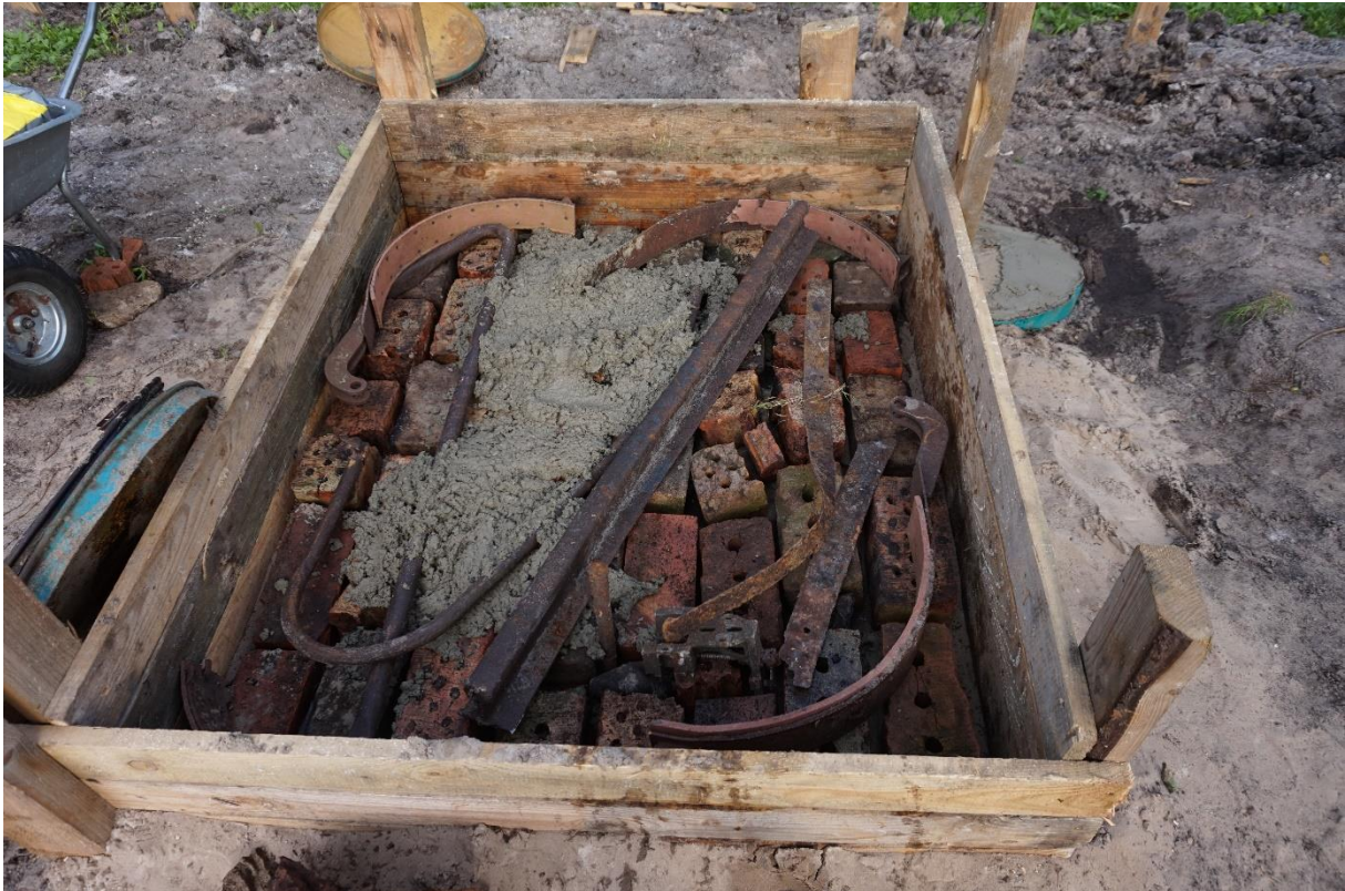
Foto 5. Kastkerise vundamendi täiteks vanad tellised ja vanaraua-armatuur
