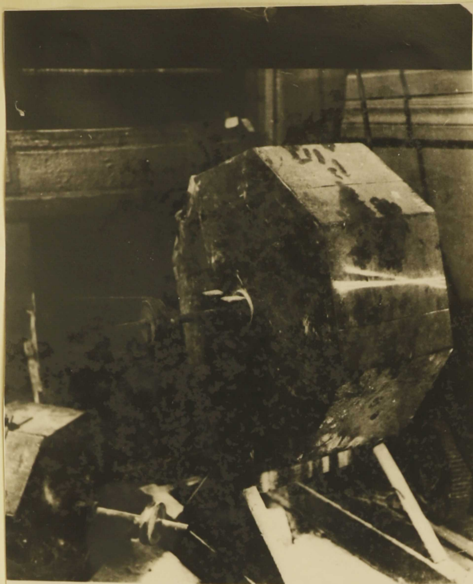
Magneesiumi ja karnooli jahvatamise trummel. Jääb ära käsitsi hõõrumine ja võimaldab materjali ära kasutada 100 %-lt.
