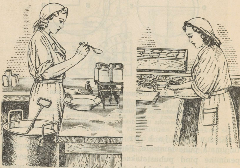
Joon. 63. Koore eelkaalumine ja -pakkimine: vasakul — kaalumine, paremal — pakkimine paberist klaasidesse, mis pealt kinnitatakse kummrõnga abil.
