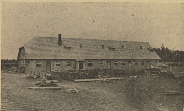
9. joonis. M. Siimu Luha asundustalu savist puhas-karjalaut. Ehitatud 1926. a. ja läks maksma ligi 9000 kr. Et vesi seinu väljast ei leotaks, on seinad laudadega kaetud.
