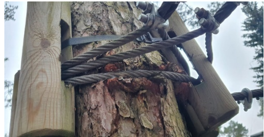
Foto 7 Pikka aega kontrollimata ja hooldamata vitskinnitus, mis juba puusse kasvab. Foto: autori erakogu
