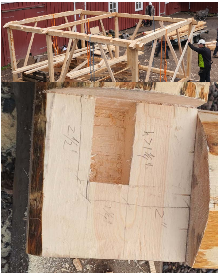
Foto II Nurgaposti jaoks ette valmistatud tapp. Alen'i ehk mõõdupulgaga käib mõõtmine ja joonistamine millimeetrite pärast muretsemata, ent piisava täpsusega ja kiiresti.. Autori fot
