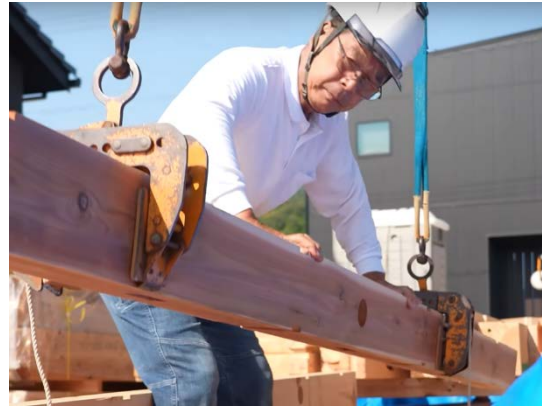
Joonis 25 - tala mittekahjustavad haaratsid lihtsustavad kraanatööd ja troppimist (Shoyan Japanese Carpenter, 2025, 4:57)
