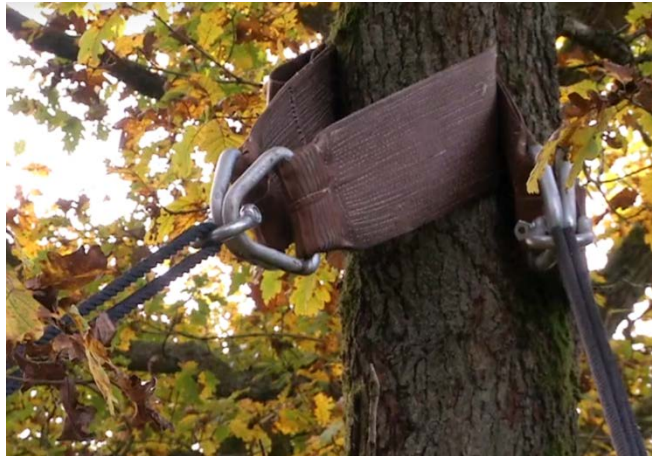
Foto 9 puuoksa külge laia kambiumikaitsmega riputatud puumaja lahendus Dom'up'i näitel. Kaader tutvustavast videost: https://youtu.be/Ogj2l_6OOCU?si=gDgKZVUSeDNNMpZ9&t=32
