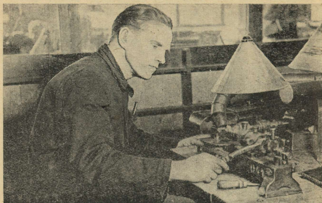
Joon. 19. Nööpide poolautomaatne graveerimismasin.
