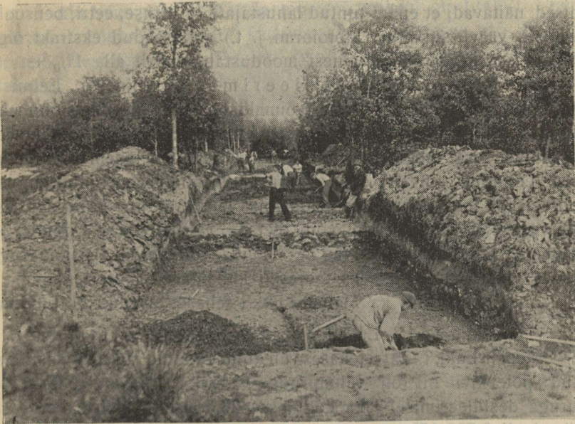
1. joon. Töö Kohtla kaevanduses. Pealmised mullakihid kõrvaldatakse käsitsi, mõnikord ka „aurulabida“ abil. Põlevkivi ja paas murtakse kihtide viisi lahti ja veetakse vagonettides kaevandusest välja. Üks tööline kaevab päevas \frac{1}{2} — \frac{3}{4} kant-sülda maad, sellest saadakse 125—150 puuda põlevkivi.
