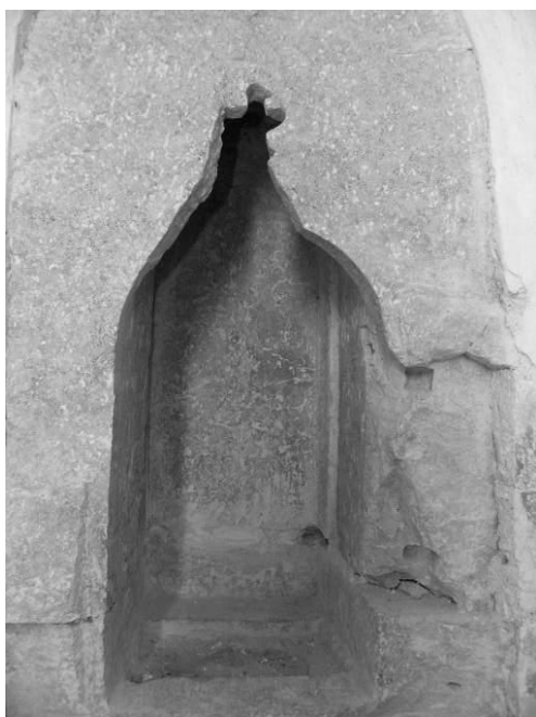
54. Sakramendiniši esikülg. Paremäl on jälgitavad hingetappide asukohad.
