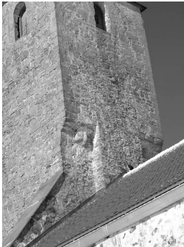
28. Pikihoone algse viilutorni idasein läänetorni inkorporeerituna.
