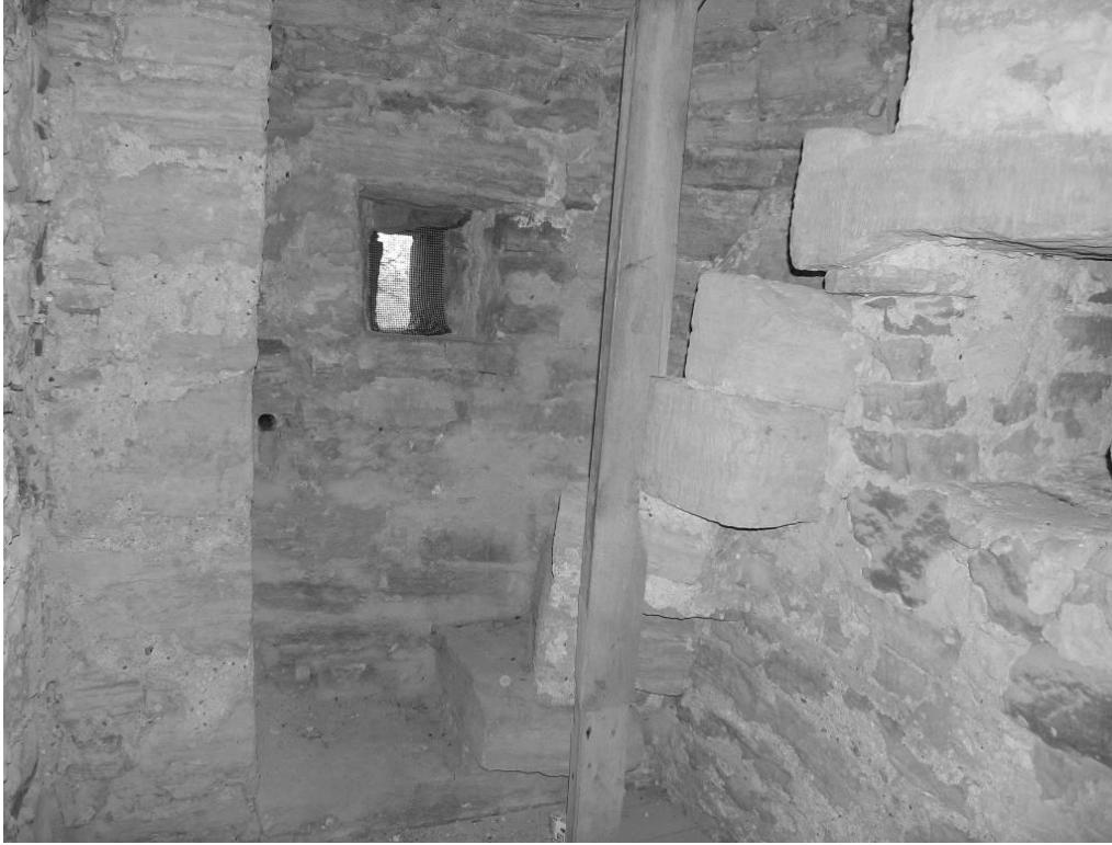
91. Tornis teine korrus ning kolmandale korrusele viiv kivitrepp.
