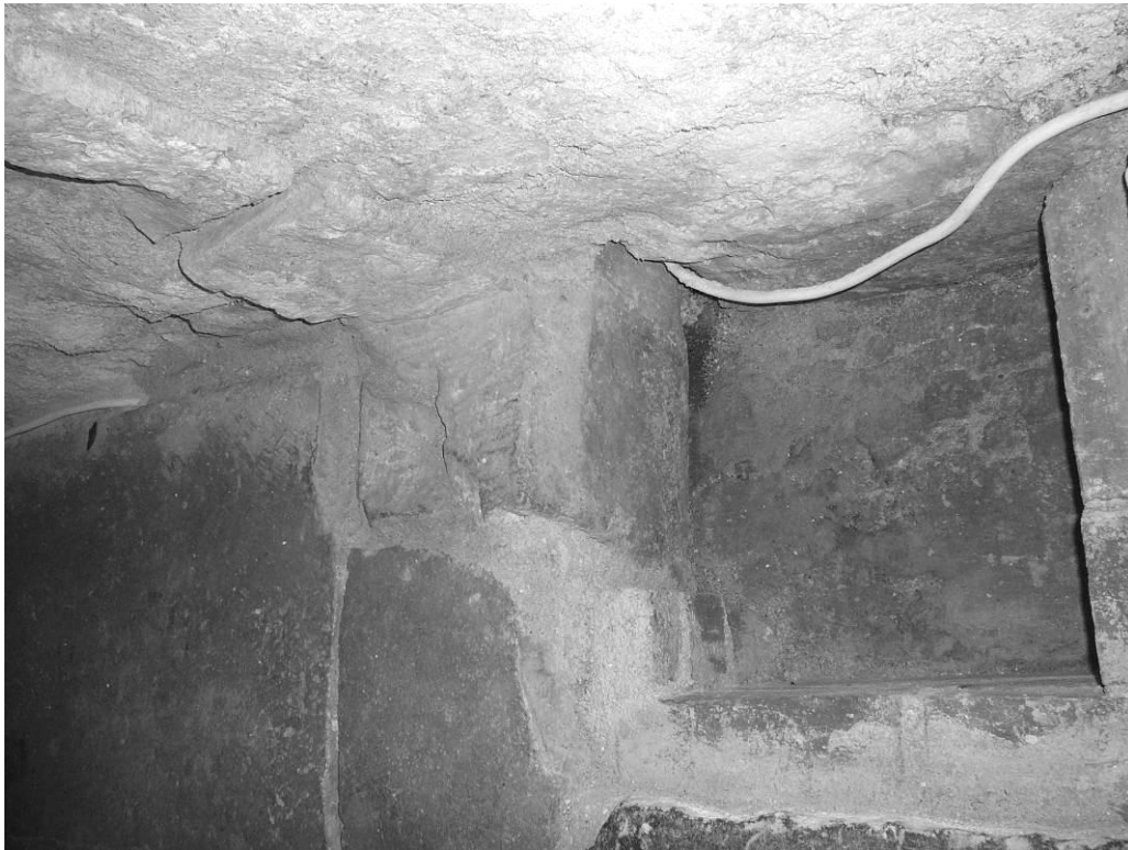
60. Koori olemasolev põrandapind ning selle all olev vanem põrand.
