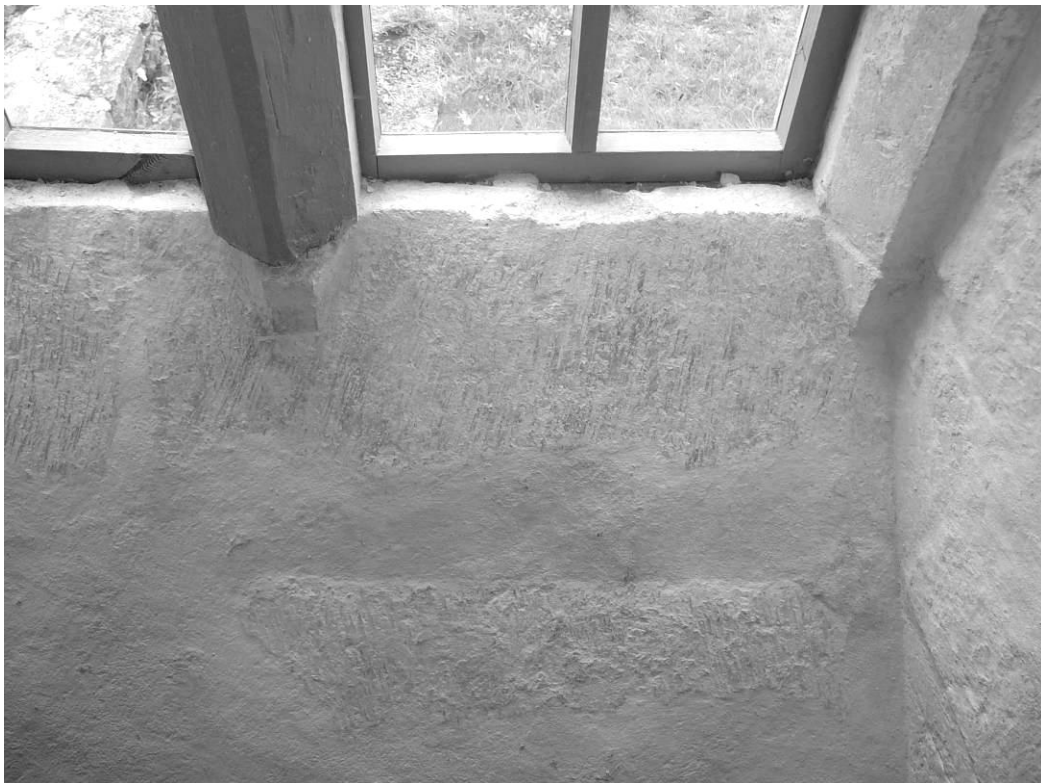
98. Koori lõunaakna raidraami fragmendid ja aknalaud monoliitsetest raiddetailidest.
