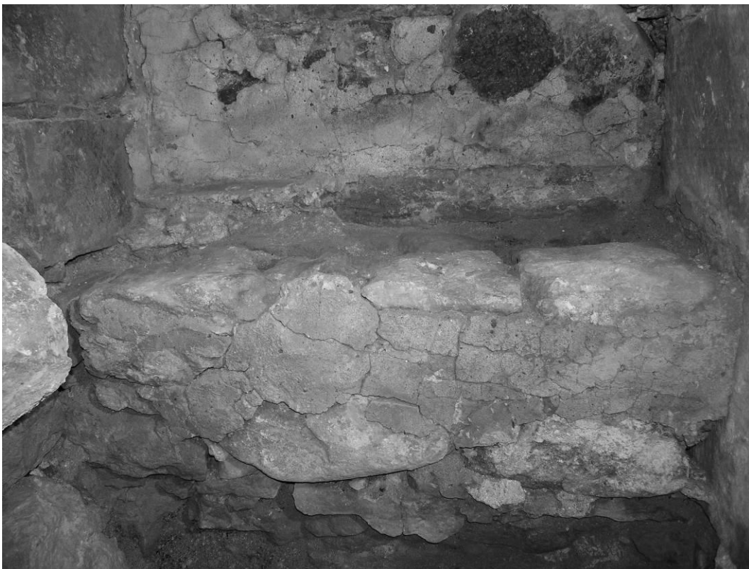
39. Pikihoone põhjaportaali mn. eeskoja niši alaosa.
