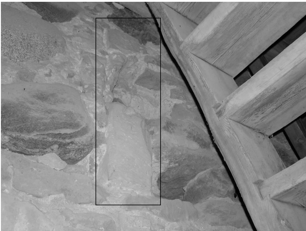
24. Pikihoone lääneportaali kohal asunud niši raidraami säilinud fragment.
