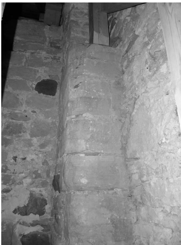
16. Algselt kavandatud pikihoone põhjapoolne tugipiit käärkambri teisel korrusel.
