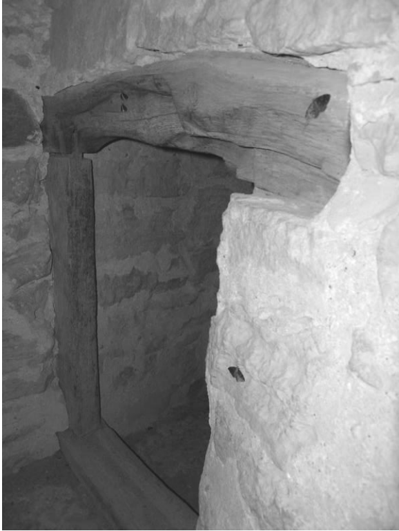
94. Tornis kolmanda korruse madalasse vahearuumi viiva ukse puidust leng.
