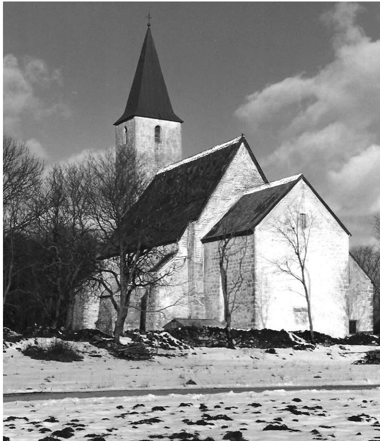
32. Pikihoone keskaegse katusekalde ja viilude rekonstruktsioon.
