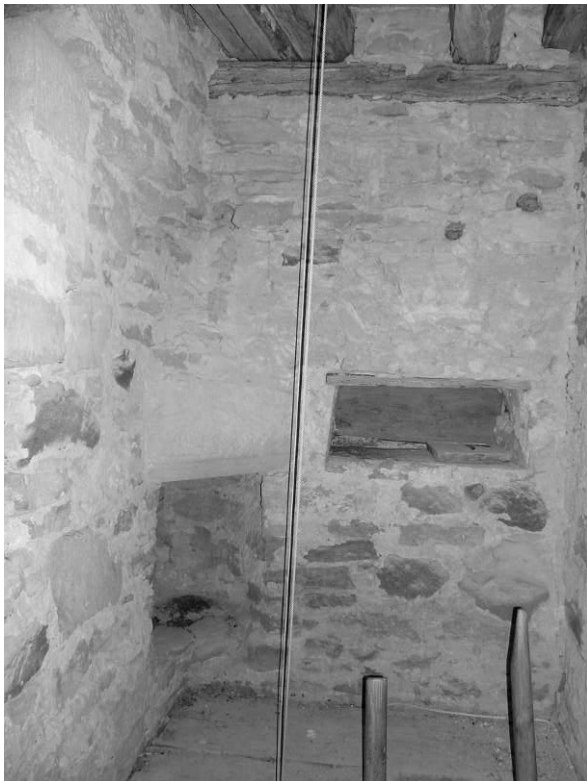
92. Tornis teise korruse kamin.
