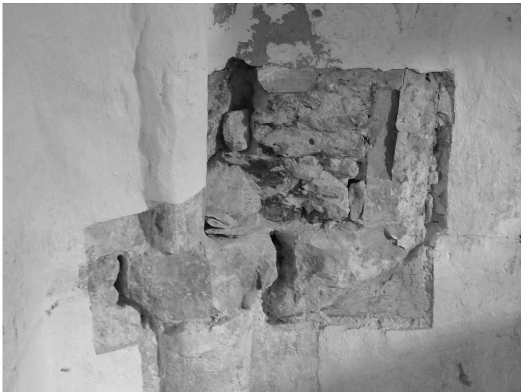
73. Pikihoone idaseina sõlm, kus on loetav algne kava konsoolidele toetuvast võlvi kandesüsteemist ning hiljem teostatud eendtugedele toetuv lahendus.
