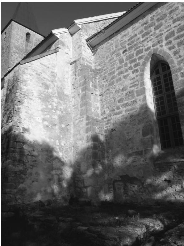
15. Koori ja pikihoone ühendusnurk ning algselt kavandatud pikihoone lõunapoolne tugipiit.
