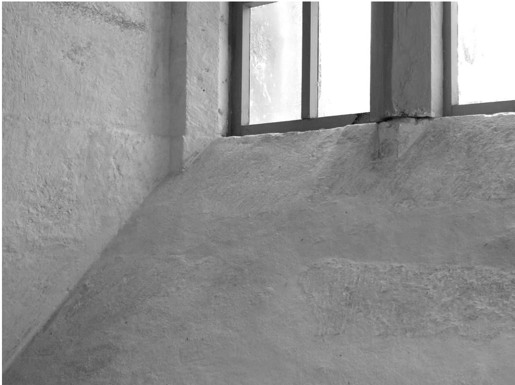
99. Koori lõunaakna palend ja aknalaud monoliitsetest raiddetailidest.
