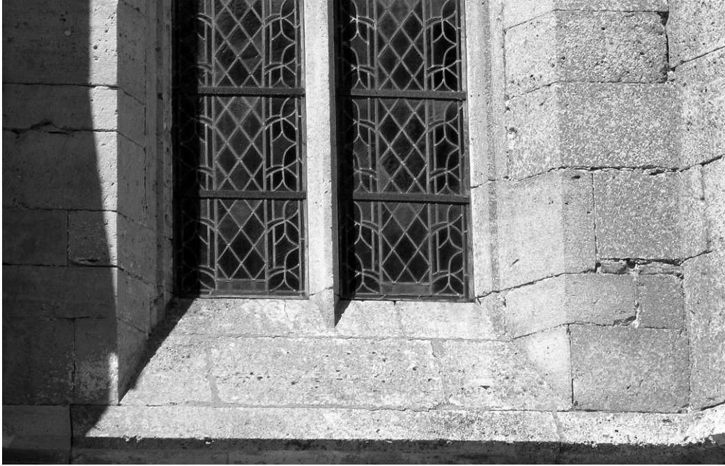
101. Valjala kiriku polügonaalse koorilõpmiku aken monoliitsetest raiddetailidest.
