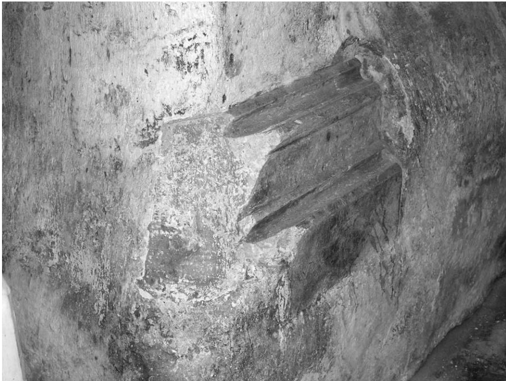
75. Pikihoone idaseina profileeritud soklikivi.
