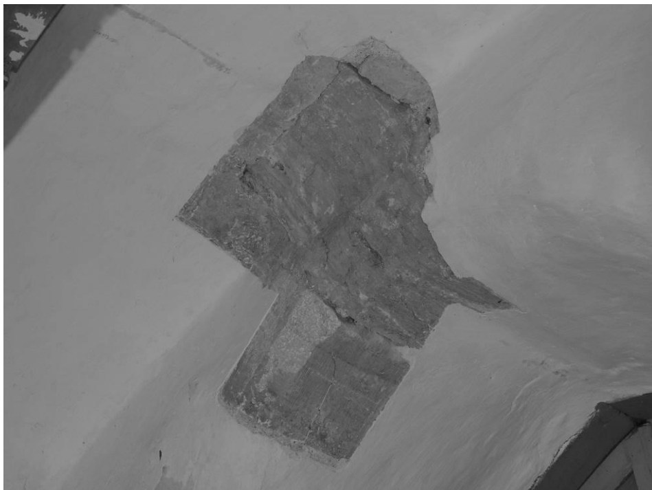
34. Pikihoone lääneportaali lukukivi ja faasitud sisenukk.
