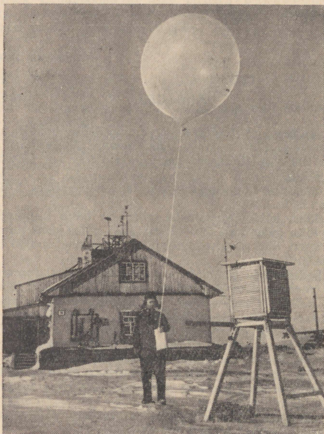
Joon. 80. Raadiosond. Paremäl meteoroloogiline onn.
