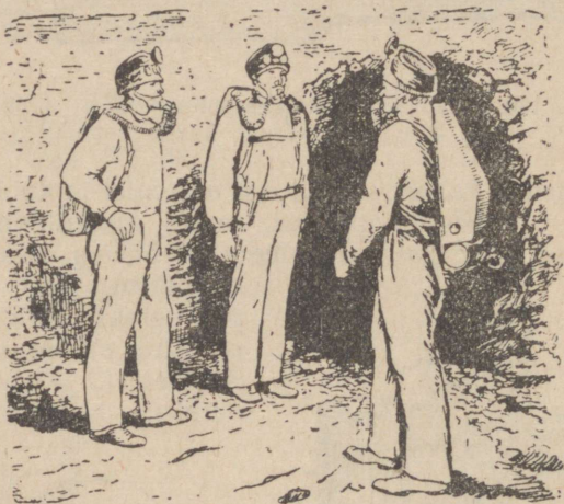
Joon. 133. Päästemeeskondadel on seljas hapnikusilindrid. Silindrist läheb hapnik gaasitorbikutaolisse aparati.
