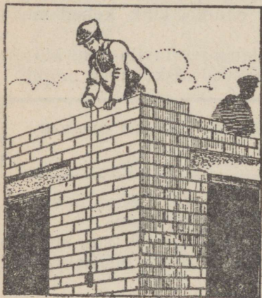
Joon. 27. Müüride vertikaalsust kontrollitakse loodi abil.
