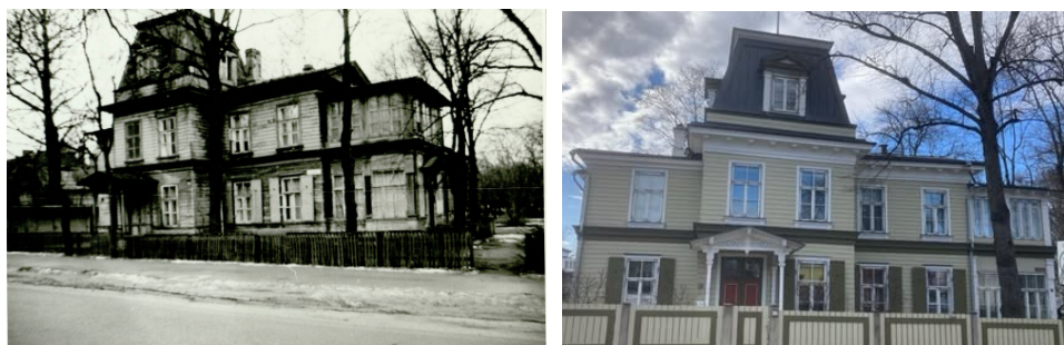
Joonis 9. Poska 53 ajalooliste ja tänapäevaste fassaadiakende võrdlus.
