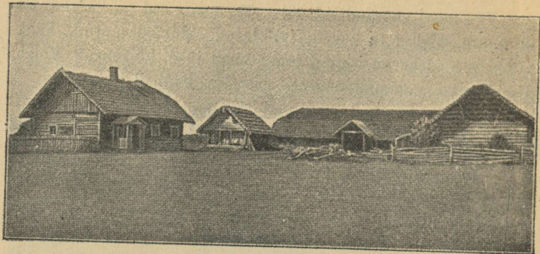
90. joonis. Leedu talu.
