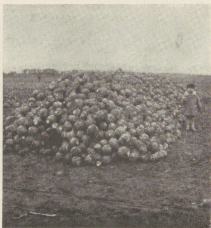
Kaalikakuhi enne kinniajamist. On näha ventilatsioonitoru ots.
