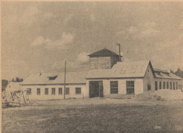
Ремонтная мастерская Тамсалуской машинно-мелиоративной станции. Построена в 1951 году.
