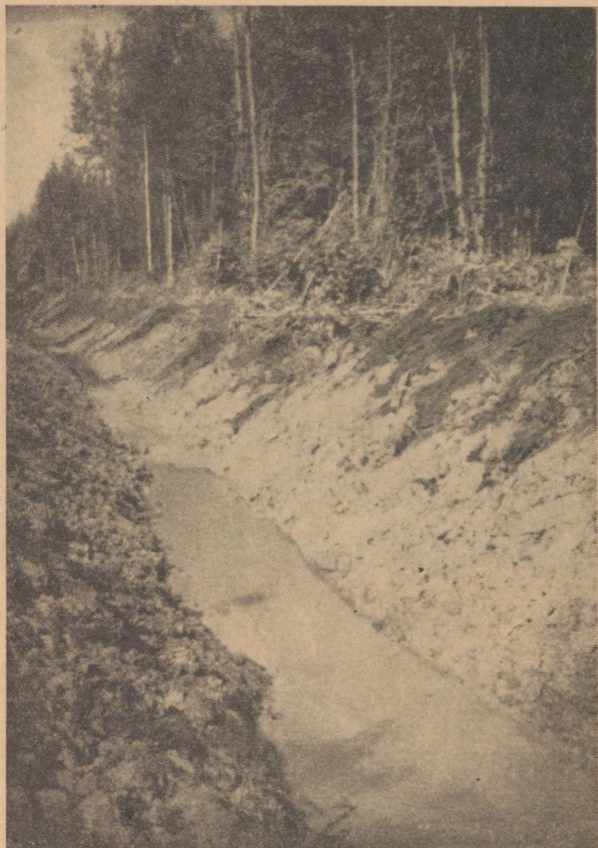
Вырытая экскаватором Э-352 магистральная канава. Лесничество Кяркна (Тартуский лесхоз).
