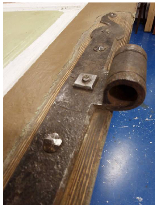
Joonis 9. Pealispinnal paistab nurk-uksehinge lati ja hingerulli lati keedukoha jälg. Näha on kaunid faasid sepise servades. (Autori foto)
