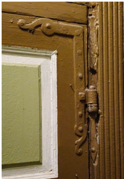
Joonis 7. Posti tn 14 välisukse parempoolse ukselehe alumine nurk-uksehing. (Autori foto)
