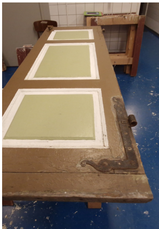
Joonis 8. Ukselehe alumise uksehinge puhastamine värvikihist. (Autori foto)
