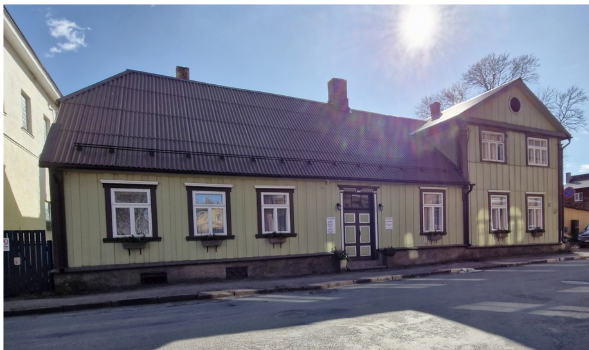
Joonis 4. Viljandi Posti 14 tänapäevase hoone esinduskül. Vaade poolkelpkatusega baroksete tunnustega majaosale (vasakul) ja sellest stiililiselt erinevale juurdeehitusele (paremal). Hooneosa fassaadile keskosaga ebasümmeetriliselt on paigaldatud tiibustega ukseportaal. Uuritavad nurk-uksehinged (sepised) on nende ukselehtede hoidjad ja vaadeldavad hoone sees. (Autori foto)
