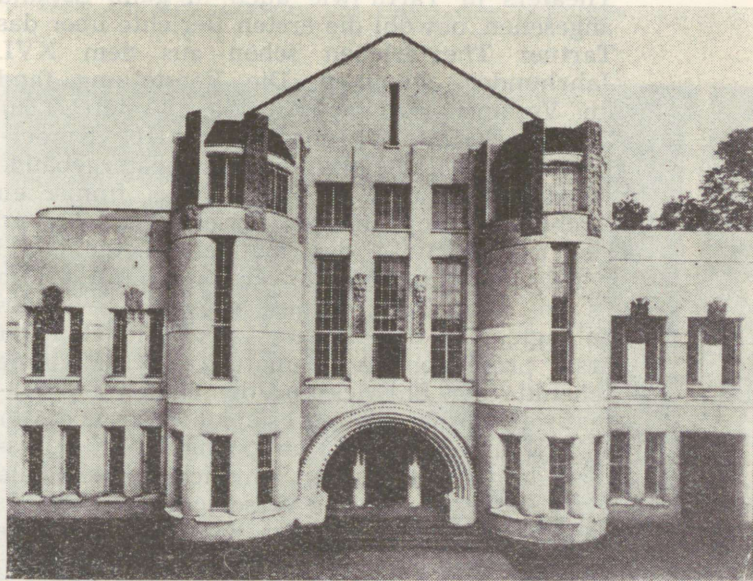
Das im Jahre 1906 erbaute Gebäude des Theaters «Vanemuine»
