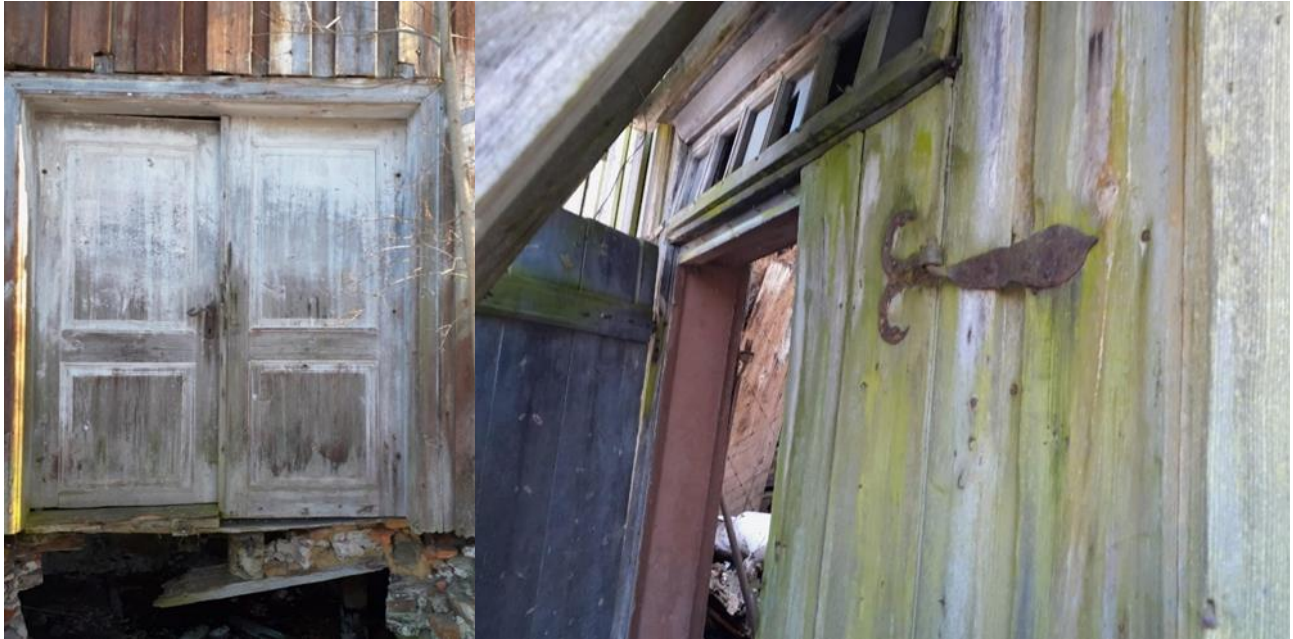
Joonis 15. Vana-Rõika/2b tööliselamu tiibuksed koos rauast lingiga. (Foto autori kogust) Joonis 16. Vana-Rõika/2b töölistemaja rauast uksehing ja mitmeruuduline valgmikaken. (Foto autori kogust)
