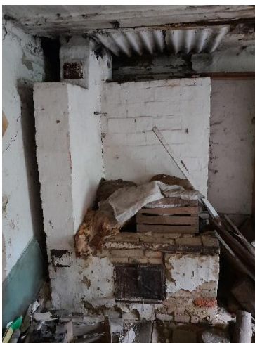
Joonis 19. Vana-Rõika/2 soemüüripliit. (Foto autori valduses)
