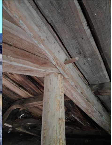
Joonis 24. Vana-Rõika/2 niiskuskahjustustega katusekonstruktsioon. (Foto autori kogust)
