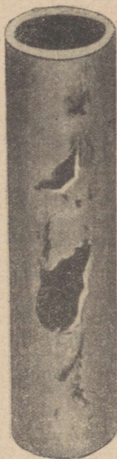
Joon. 5. Toru korrosioon.
