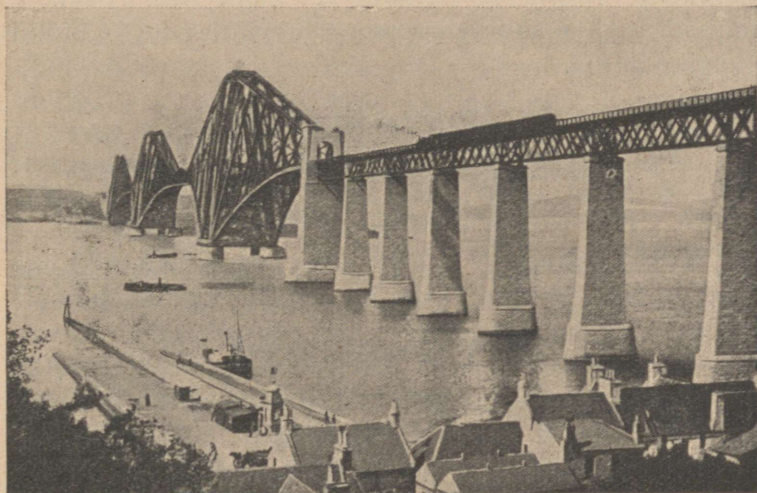
110. joon. Firth of Forth sild Inglismaal, 2,5 km pikk, üks maailma pikemaid sildu. Kahe keskmise kaare laius 520 m kumbki. Ehituskunsti imetöö.
