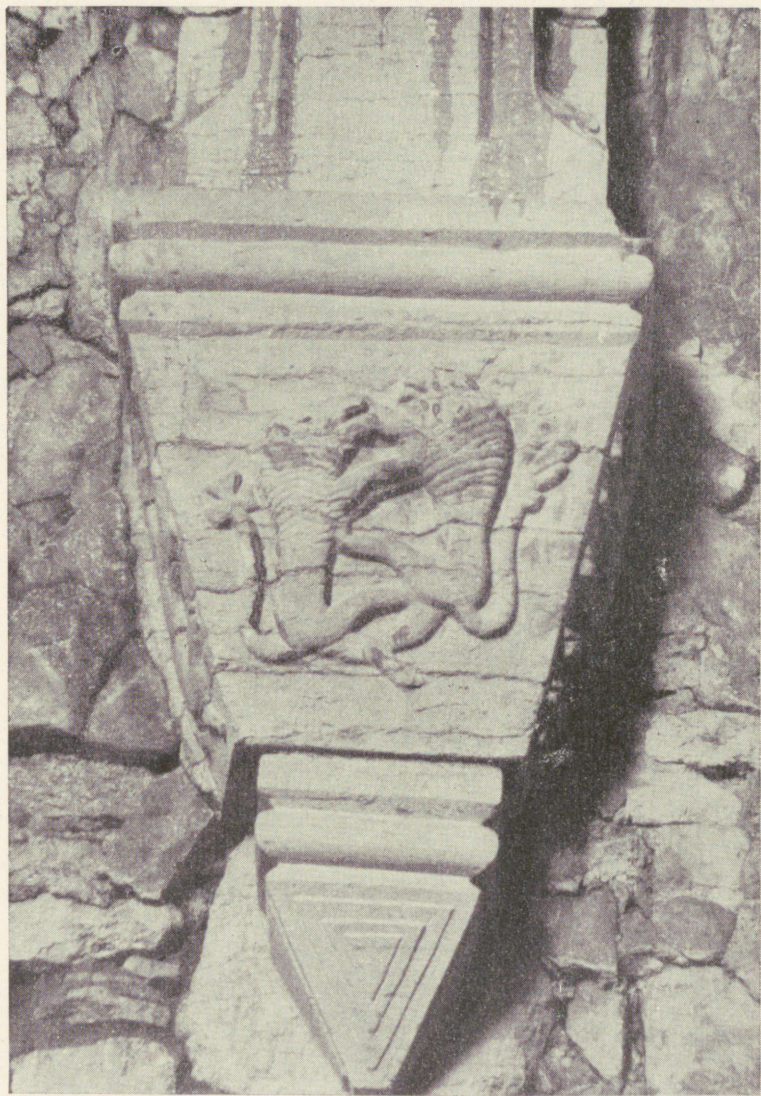
7. Idapoolse vöödekaare konsool kiriku põhjaseinal. Консоль восточной подпружной арки на северной стене церкви Console supporting east groin at north wall of church.
