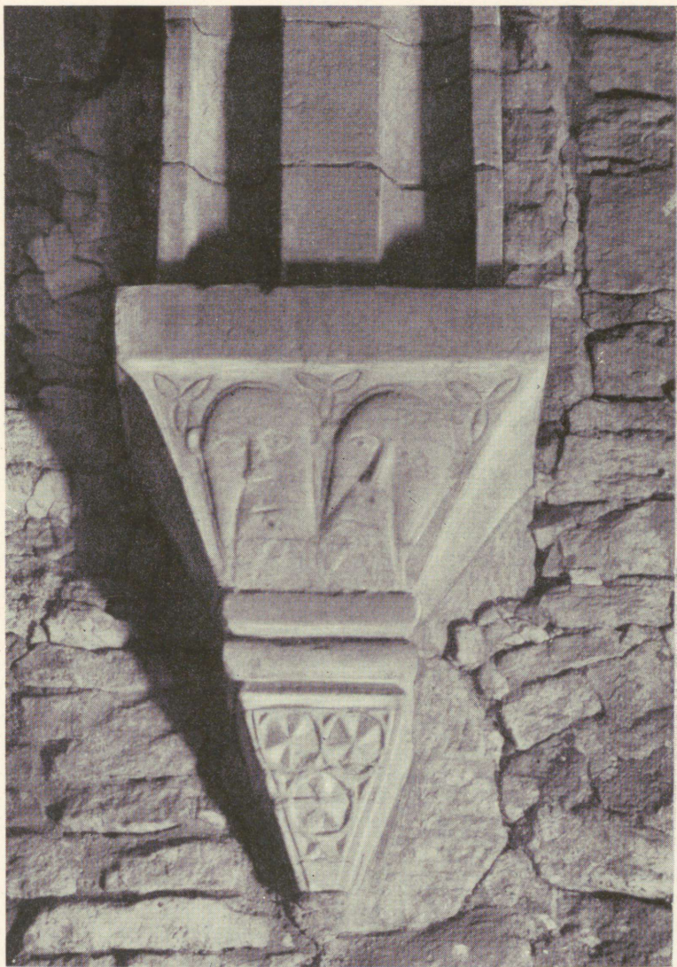
9. Idaroolse vöödekaare konsool kiriku lõunaseinal. Консоль восточной подпружной арки на южной стене церкви. Console supporting east groin at south wall of church.
