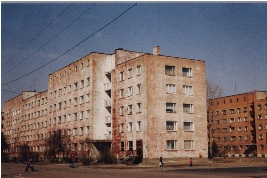
Soome tüüpprojekti järgi 1970.-80. aastatel ehitatud elamud Lõuna mikrorajoonis.
