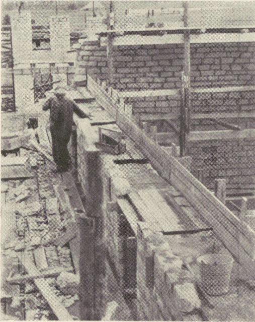
Фото 35. Перемычка над окном промышленного здания.
