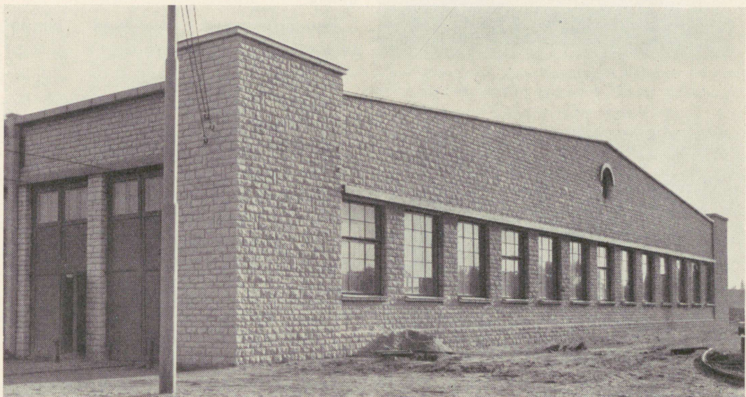
Фото 18. Трамвайный парк, из плитняка.
