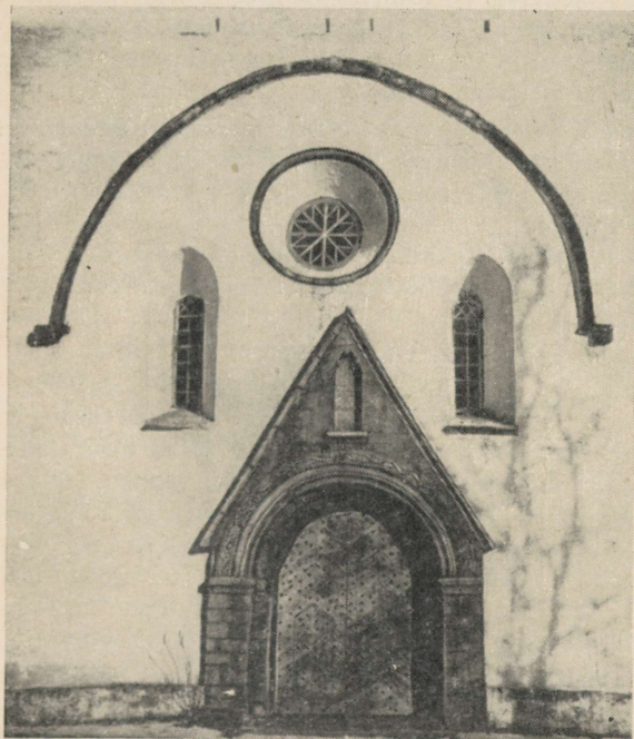
Valjala kiriku läänefassaad.
