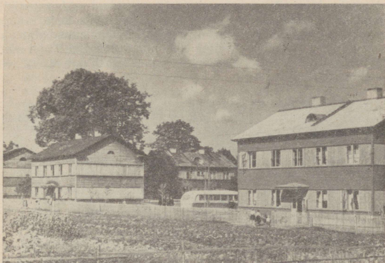
Joon. 91. Kaheksakorterilised tööliselamud Tudu metsapunktis.
