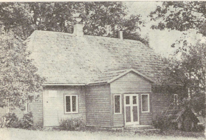
Tinno talu elumaja Karaskil (1968. a. pärast kapitaalremonti). Nende seinte vahel kasvasid üles R. Roht ja V. Uibopuu (1968)
