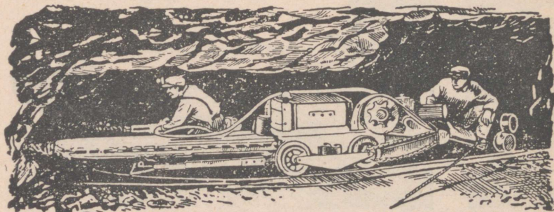
Joon. 19. Raiemasina töö šahtis.
