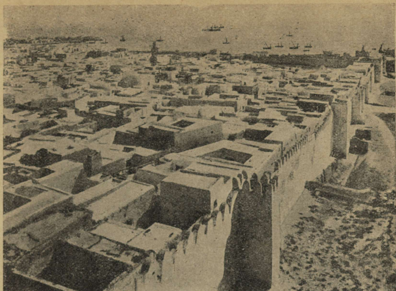
28. joonis. Tuneesia linna (Susa) üldvaade. Esiplaanil paremal näha vana linnamüür. Keskel ja pahemal ees sisehooviga ja lamekatusega majad. Tänavad kitsad ja kõverad. Lamedaid katuseid kasutatakse lamamiseks ja mõnulemiseks, vahel ka magamiseks.
