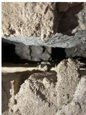
Joonis nr.26. Maakivimüüri ja tellisseina õhuvahe.
