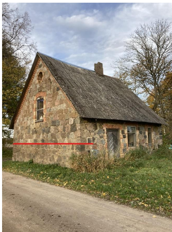
Joonis nr.20. Müüriladumise erisus
