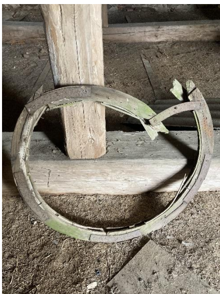
Joonis nr. 59. Algupärane otsaviilu aknaraam
