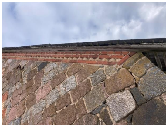
Joonis nr.21. Otsaviilu telliskarniis
