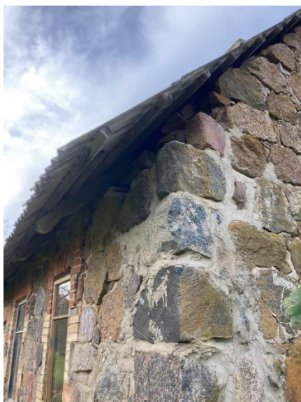
Joonis nr.34. Müüritisest välja vajunud kivid
