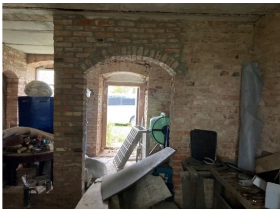
Joonis nr. 52. Siseseinte tellisladu
