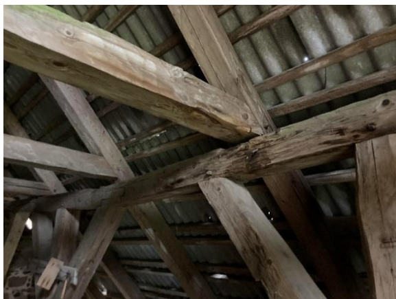
Joonis nr. 47. Mädanik ja vajunud toolvärk
