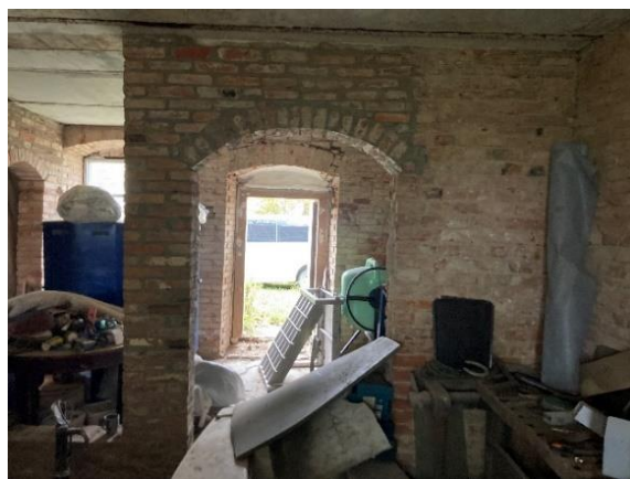
Joonis nr.25. Sisesenad ja vaheseina võlv
