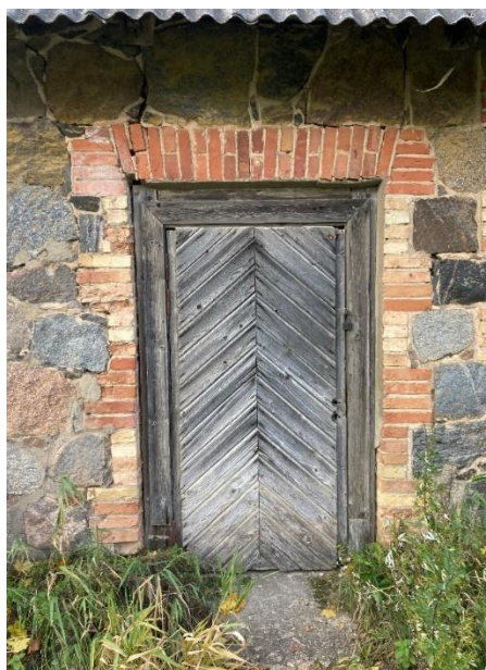
Joonis nr.23. Välisukse ja telliskvaader
