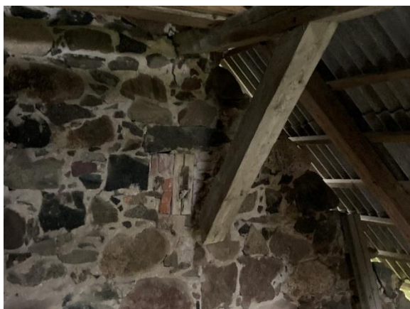
Joonis nr. 49. Seinast lahti tulnud diagonaal
