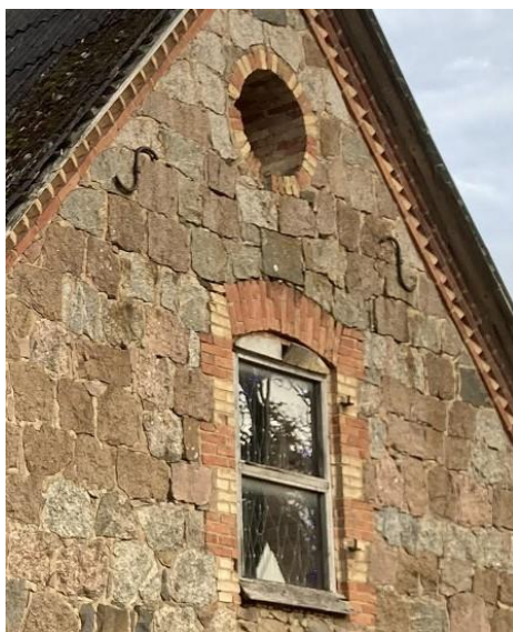
Joonis nr.24. Sepistatud müüriankrud
