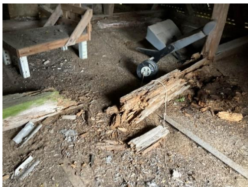
Joonis nr. 46. Tolvärki toetav laetala on pehastunud
