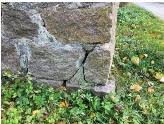
Joonis nr.30. Vundamendi vajumine
