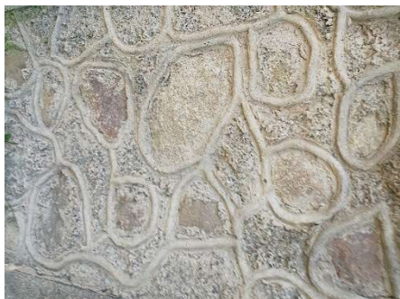
Foto 18. Vundament Supilinna linnaosas Tartus 09.07.2024. Tiina Angerjärve foto.
