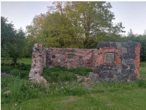
Foto 1a. Esimesel pildil on müürilt ja müüri äärest eemaldatud puud. Foto 1b. Teisel pildil on kogu hoone ümbruse juba puhastanud. Eemaldatud on müürilt kõik lahtised ja kukkumisohtlikud kivid.
