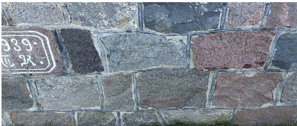
Foto 1. Kumervuuk, kus valge lubimördi vuugi keskele on kantud ümar, kergelt väljaulatuv tüme mördijoon. Elumaja vundament 1939. Külli Loometsa foto 25.06.2024.
