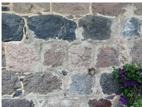
Foto 14. Parandused tsementmördiga. Esteetikaga pole rõhku pandud. Kuudeküla talu. Viljandi mk. 17.07.2024. Tiina Angerjärve foto.
