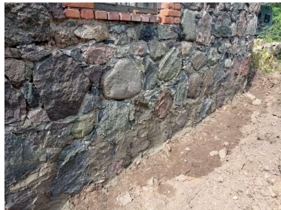
Foto 2a. Esimesel pildil on müüriäär lahti kaevatud ja ootab survepesuriga puhastamist. Foto 2b. Teisel pildil on maa alla jääv osa täidetud müüriseguga Sakret ZM.
