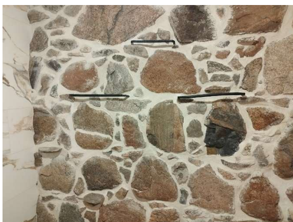
Foto 5. Ümaratest lõhkumata kividest laotud müür Tartumaal Lepiku talus 2024. Tiina Angerjärve foto.
