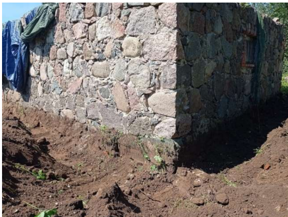
Foto 2a. Esimesel pildil on müüriäär lahti kaevatud ja ootab survepesuriga puhastamist. Foto 2b. Teisel pildil on maa alla jääv osa täidetud müüriseguga Sakret ZM.
