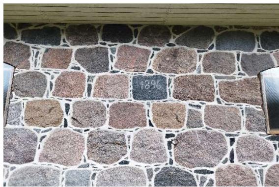
Foto 4. Rõhtsatsesse ridadesse laotud lõhutud kivid, mis tekitavad korrapärase vuugimustri, kus suuremad tühimikud täidetakse kivikiiludega 2024. Tiina Angerjärve foto.
