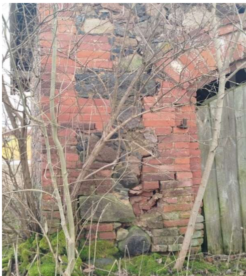
Foto 39. Praod müüris. Müüri äärde istutatud Sireli heki juurestik lõhub hoonet. Tammistu, Tartu mk. 06.03.2025. Tiina Angerjärve foto.
