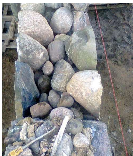
Foto 7. Müür enne mördiga täitmist. (Peebo 2016). Alo Peebo foto.
