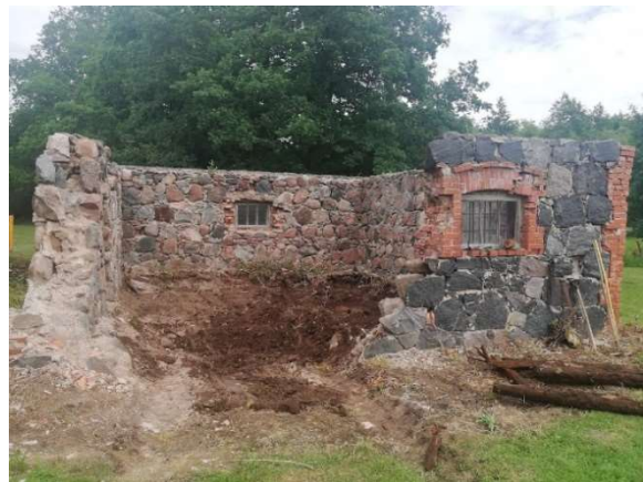
Foto 1a. Esimesel pildil on müürilt ja müüri äärest eemaldatud puud. Foto 1b. Teisel pildil on kogu hoone ümbruse juba puhastanud. Eemaldatud on müürilt kõik lahtised ja kukkumisohtlikud kivid.
