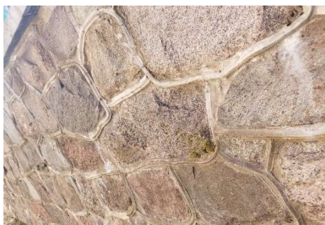
Foto 15. Jaani kiriku aiämüür. Tartu. 09.07.2024. Kolmnurkne vuuk. Tiina Angerjärve foto.
