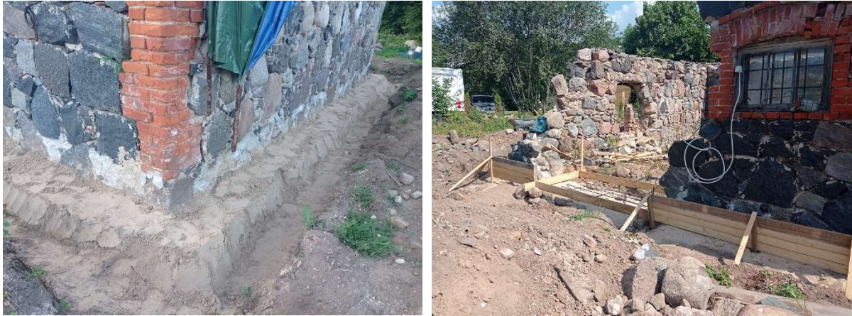
Foto 3a. Esimesel pildil on müüriäär tagasi täidetud kruusa ja liivaga. Foto 3b. Teisel pildil on näha armeeritud raketist ehk saalungit, mis on valmis betoonivaluks ja ootab betooniautot.
