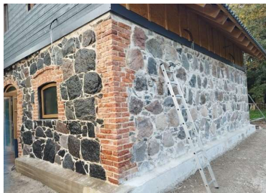
Foto 44. Lepiku talu. Nanoteriga töödeldud müür paari tundi pärast töötlemist. Võrdluseks puhastamata müür 11.09.2023. Tiina Angerjärve foto.
