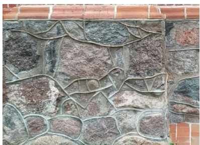
Foto 5. Tartu Jaani kiriku müür. 09.07.2025 Tiina Angerjäv fotod.
