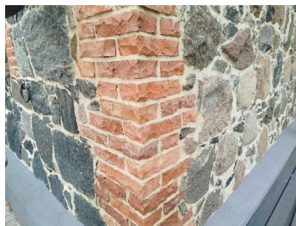
Foto 6. Segaladumine, maja esikülg on lõhutud tumedast kivist ja maja ülejäänud kolm külge on ümaratest lõhkumata erinevatest kivimitest 2023. Tiina Angerjärve foto.
