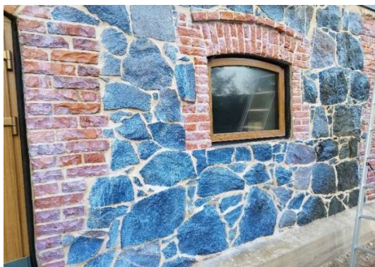
Foto 43. Lepiku talu. Värskelt peale kantud Nanoteri maakiviseinal 11.09.2023. Tiina Angerjärve foto.
