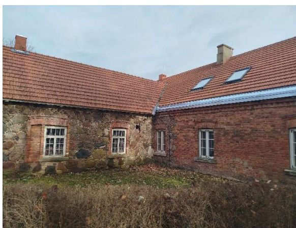
Foto 5. Tammistu mõisa korda tehtud piimakoda. Muinsuskaitse objekt. Tartu mk. 06.03.2025.
