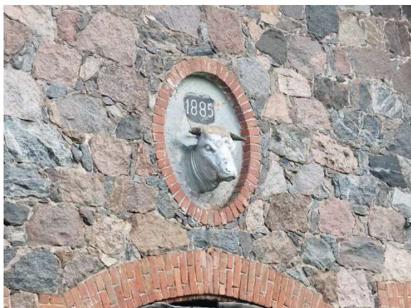
Foto 1. Pulli mõisa lehmalaud, Viljandimaa. Tiina Angerjärve foto.
