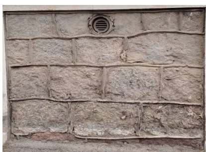
Foto 9. V-vuuk. Vundament Tartus 2025. Tiina Angerjärve foto.
