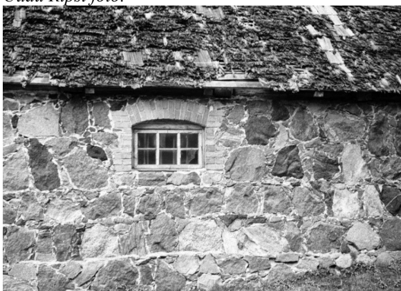
Foto 13. Maakiviseina ja akna lähivaade Visusti küla Kapupoolt talu laut. EVM F 84:270. K. Tihase (1949-1954 fotokogu) foto.
