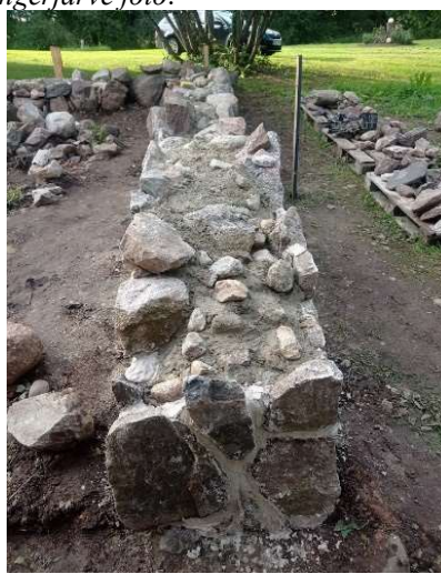
Foto 8. Müür on täidetud lubi-tsementmördiga 2024. Tiina Angerjärve foto.
