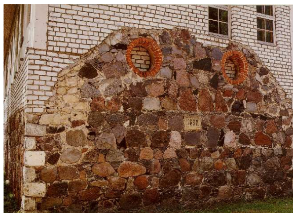
Foto 15. Maakividest vundament Aravetel, millele on laotud tellistest hoone 2004.a. Vundament aastast 1898. PM F 3557:154. Rene Viljati foto.
