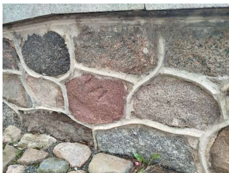
Foto 19. Tartu Jaani kiriku vundament. 19.04.2025. Tiina Angerjärve foto.
