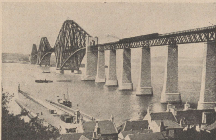
125. joon. Firth of Forth sild Inglismaal, 2,5 km pikk, üks maailma pikemaist sildadest. Kahe keskmise kaare laius 520 m kumbki. Ehituskunsti imetöö.
