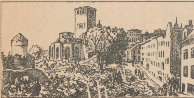
Один из разрушенных участков Таллина. Purustatud Tallinna vaade.
