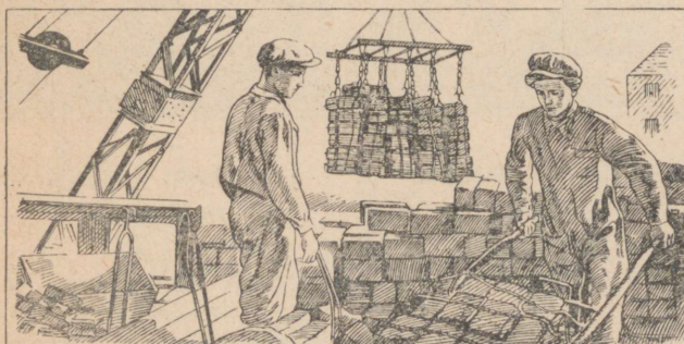
Механизированная стройка дома из сланцезольных кирпичей. Mehhaniseeritud majaehitamine põlevkivituha- tellistest.
