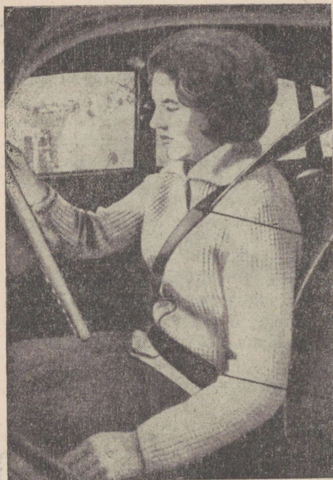
Joon. 4. Otstarbekas kaitserihm. a — elastne õlarihm, mis suure koormuse puhul võib veidi venida, b — mitteveniv keharihm.
