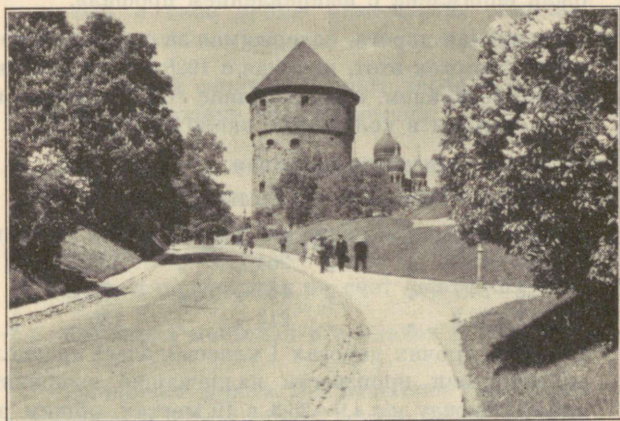
Битумный покров поверхности на Komandandi ул.-це.
