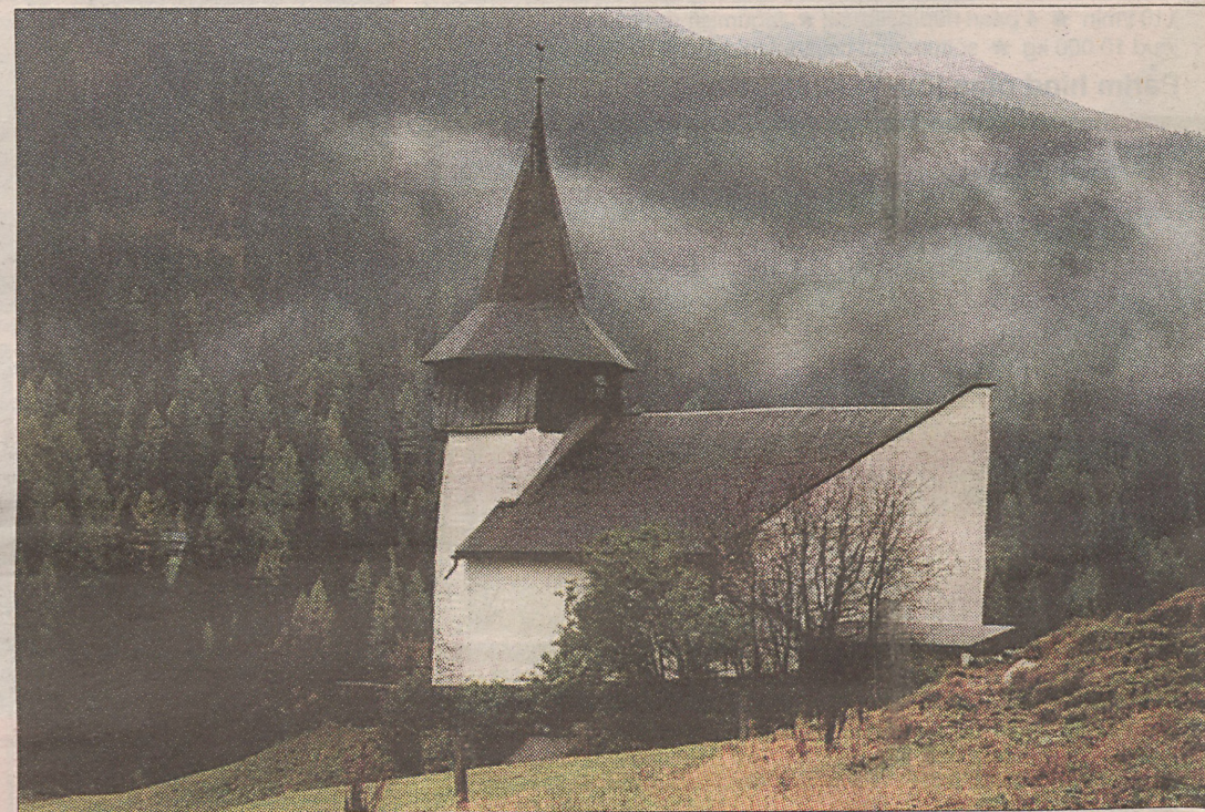
Frauenkirche kirik Davosi lähedal. Laevanina sarnane sein toimib laviinimurdjana – suunab lumevoolu ehitistest mööda.
