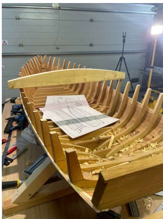
Foto 11. Tekkpalk. Pruss piki laevakaari vahetult tekkpalkide all, millele kinnitub laevatekk, Siim Rikker
