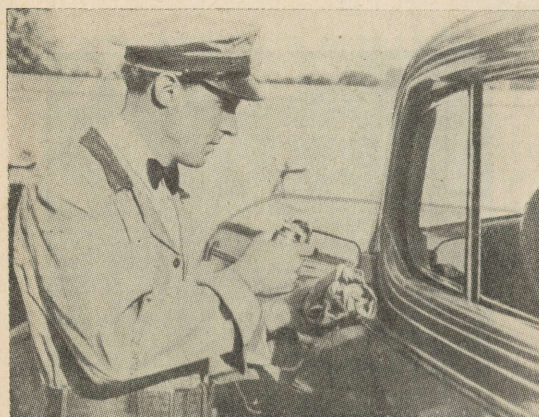
Joonis 176. Tilk vedelat õli uksehingedele.
