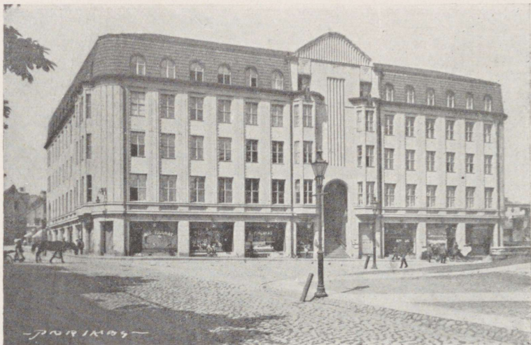
Bureau central de la société agricole „Estonia“ à Tallinn.
