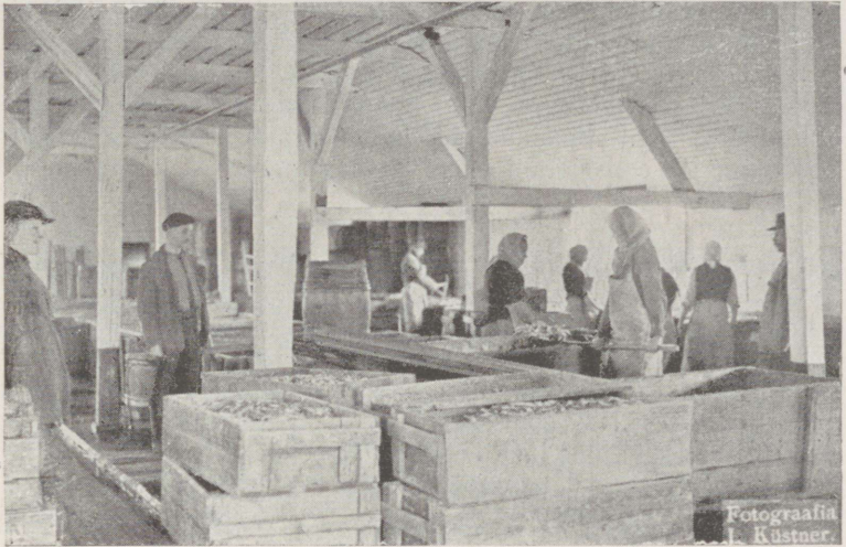
Etablissement de salaison de poissons à Pärnu.
