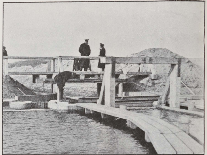
Fallschleuse von oben gesehen. Die Kammer ist gefüllt. Im Hintergrunde die Böschungen der Rinne.
