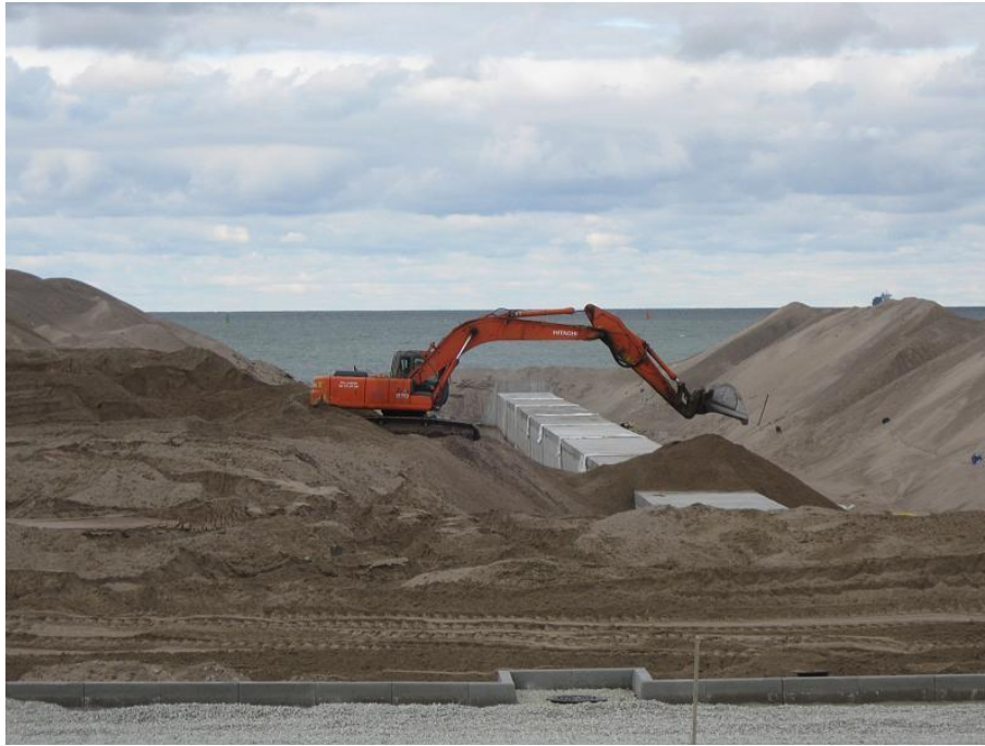
Joonis 17. Seismilisel profiilil 690 m kaugusel asuva tunneli rajamine. (AS Merko Ehitus Eesti, 2003 – 2005 a)
