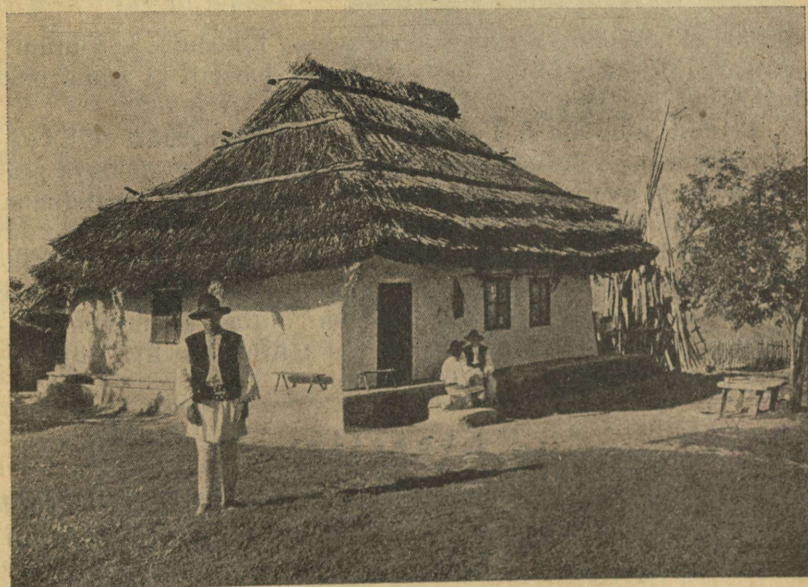
Joon. 95. Taluelamu tüüp Bessaraabiast. Majal on etteulatav vundament ja õlgkatus. Majad ehitatakse siin savist.
