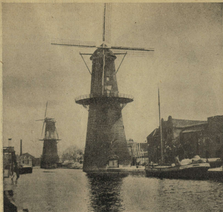
Joon. 43. Hollandi maastiku omapäraks on kanalid ja tuulikud. Tuulikute abil pannakse liikuma veepumbad maa kuivatamiseks.
